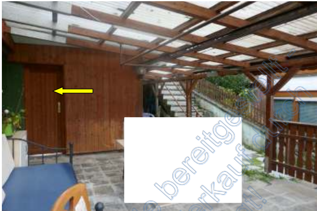
Blick auf die Terrasse im Erdgeschoss Richtung Waschküche (gelber Pfeil) und Treppenanlage.
