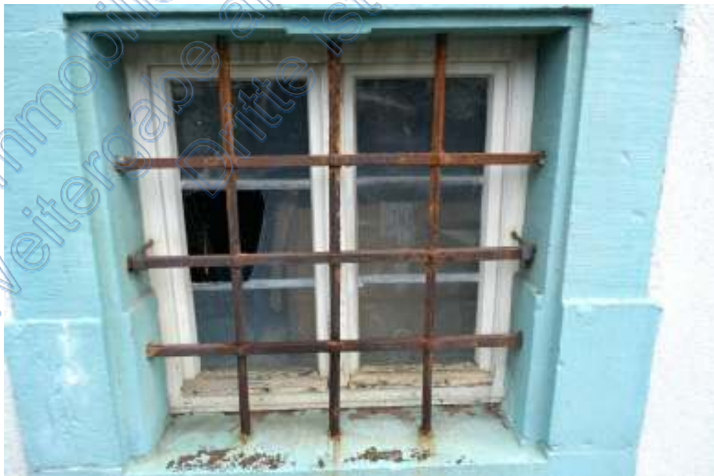
Die Kellerfenster sowie die Fenster des Dachgeschosses bedürfen einer Erneuerung.
