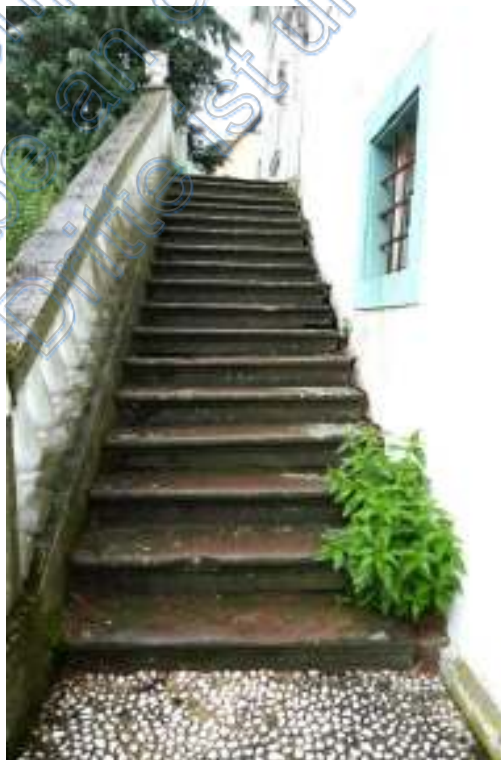
Blick auf die Zugangstreppe zur Wohnung im Erdgeschoss. Der Treppenan-schluss an die Gebäudefassade ist unsauber gearbeitet.
