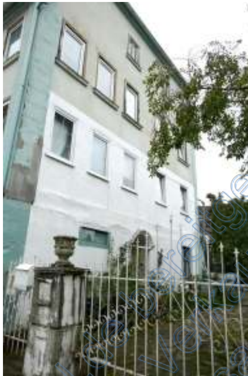
Südansicht des Wohnhauses. An der Fassade sind vereinzelt Risse sowie Farb- und Putzabplatzungen sichtbar.
