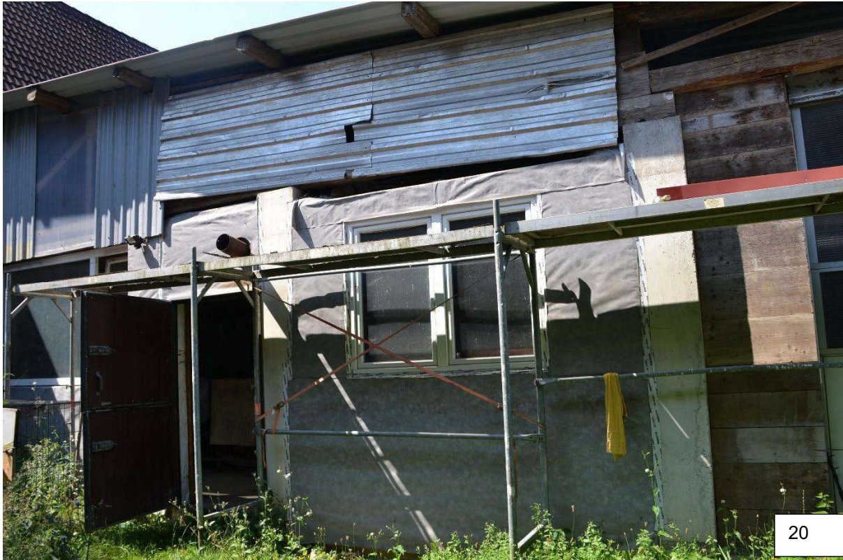
Ost-Fassade der ehemaligen Scheune
