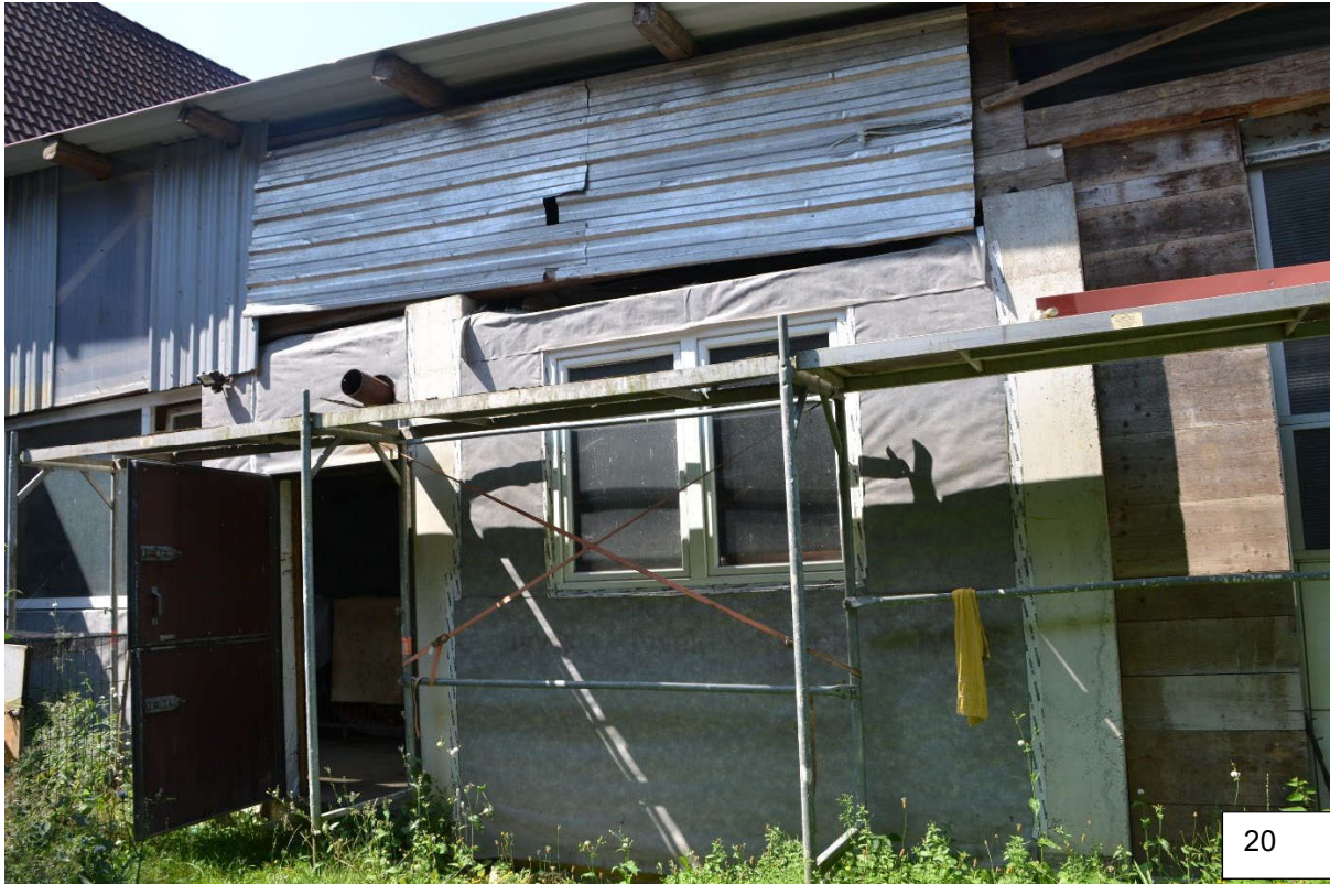
Ost-Fassade der ehemaligen Scheune
