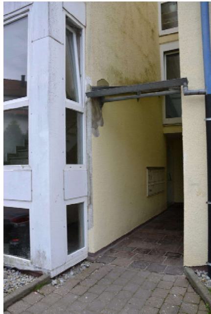
Bild 11: Nordansicht Maulacher Straße 29, Hauseingangsbereich
