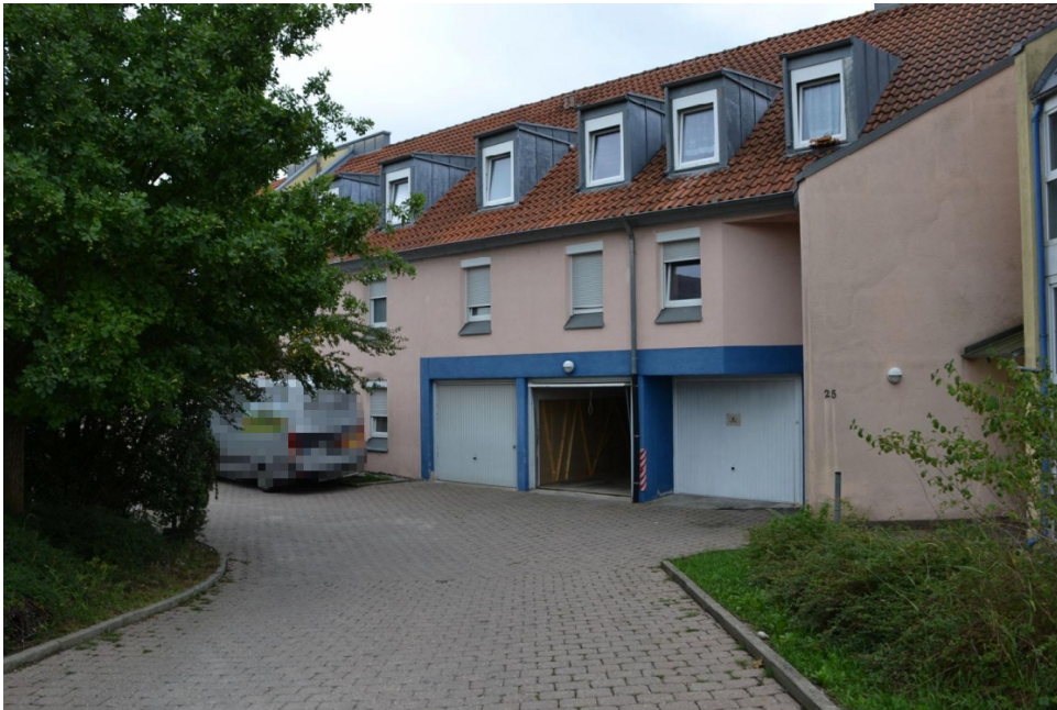
Bild 5: Nordwestansicht Maulacher Straße 27 (mittleres Gebäude)
