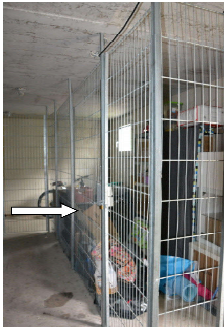
Bild 18: Erdgeschoss Abstellraum -Bewertungsobjekt Wohnung Nr. 18, Pfeil
