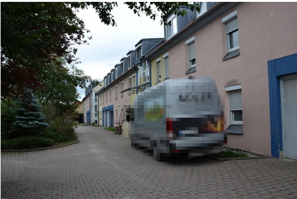
Bild 6: Nordwestansicht Maulacher Straße 27 und 29
