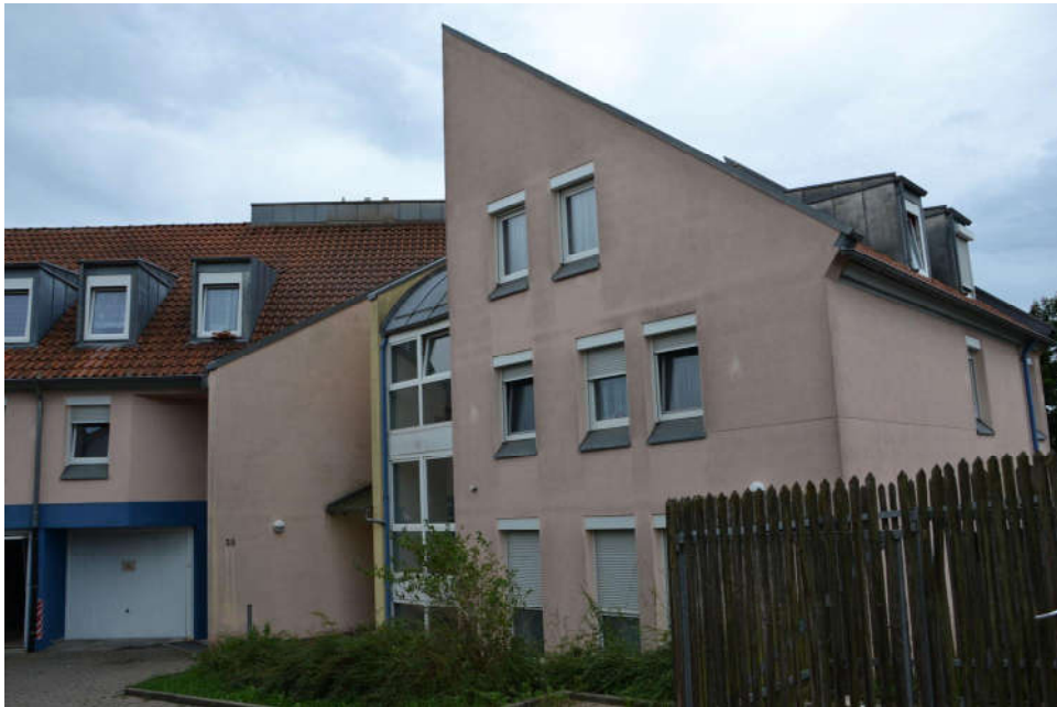
Bild 3: Nordansicht Maulacher Straße 25 (rechtes Gebäude)
