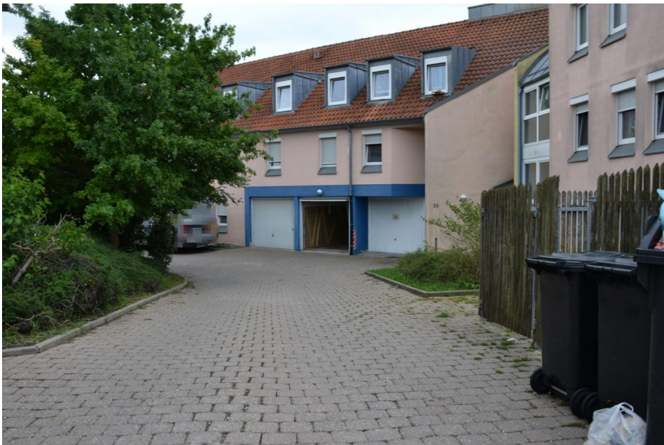
Bild 4: Nordwestansicht der Zufahrt
