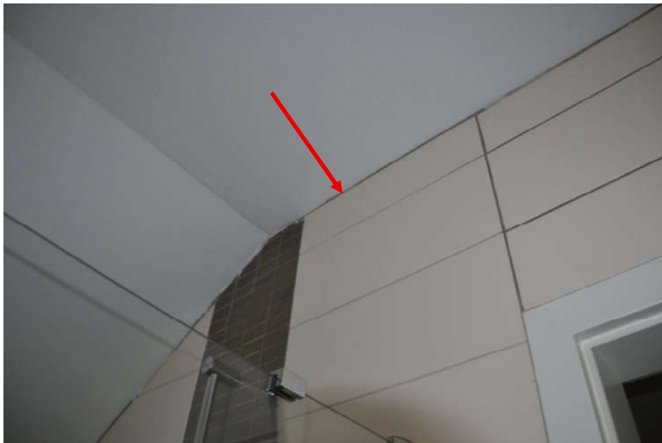
Bild 20: Dachgeschoss, Bad, Verlegearbeiten der Wandfliesen in Eigenregie
