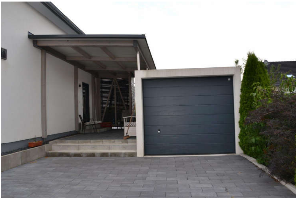
Bild 6: Südensicht Überdachung und Fertiggarage
