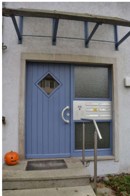
Bild 10: Nordansicht, Hauseingang, rechts
