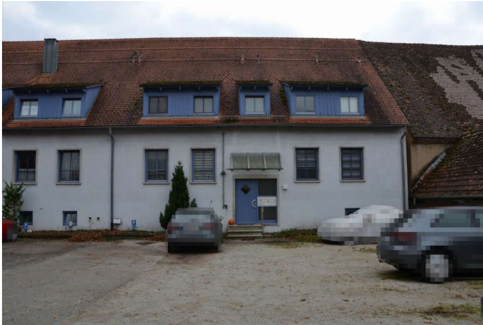
Bild 3: Nordansicht Hauseingangsbereich rechts (Eingang zum Bewertungsobjekt Nr. 4)
