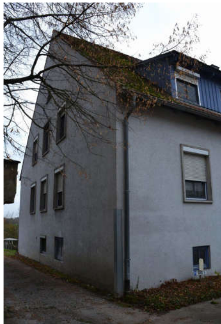
Bild 4: Nordostansicht des Mehrfamilienhauses
