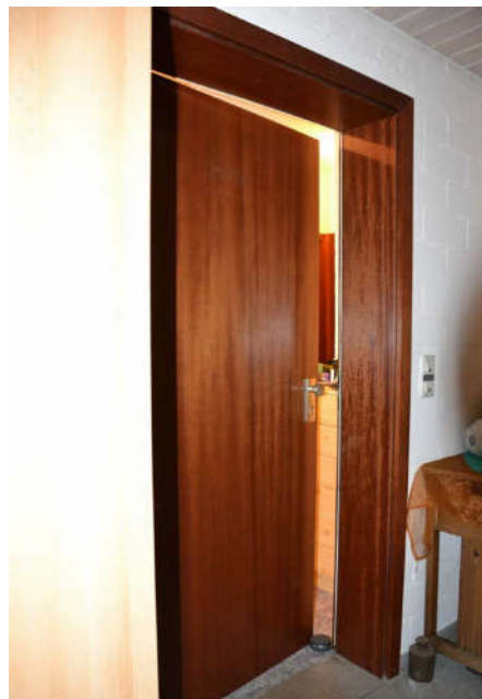
Bild 14: Untergeschoss Wohnungseingangstür (Bewertungsobjekt), 2-Zimmerwohnung Nr. 4
