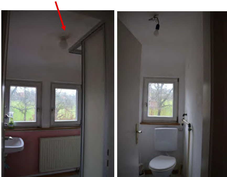
Bild 27a,b: Dachgeschoss Duschbad, nicht zeitgemäß, ehemaliger Feuchtigkeitsschaden an der Decke (Pfeil); WC (rechtes Foto)
