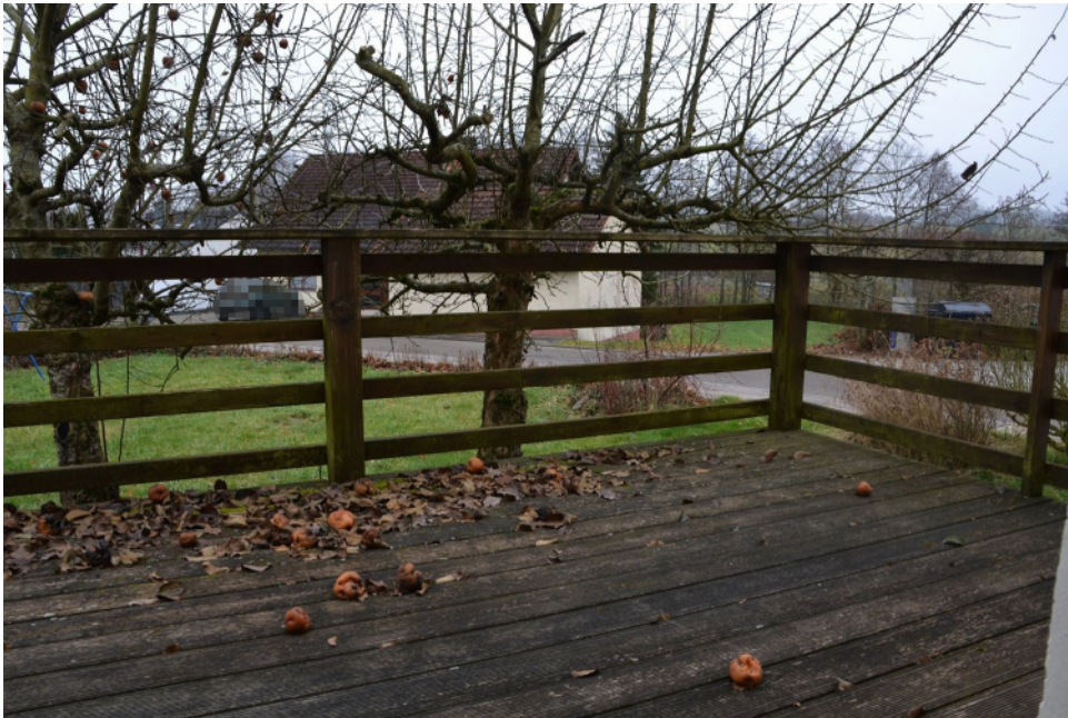
Bild 23: Erdgeschoss Terrasse, Holz, nicht rutschsicher
