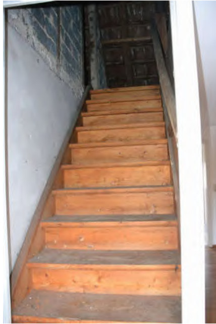
Bild 31: Dachgeschoss Geschosstreppe zum Dachspitz
