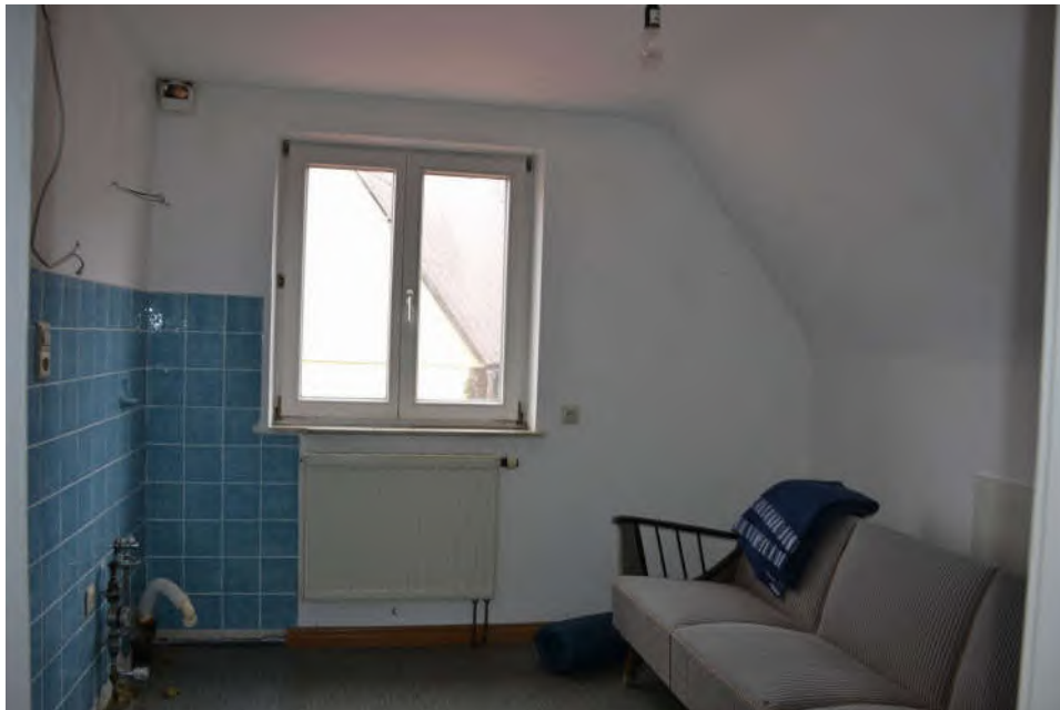
Bild 28: Dachgeschoss ehemalige Küche
