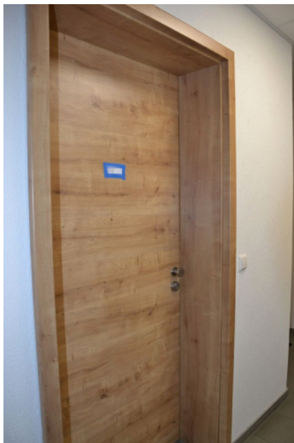
Bild 10: 6. Obergeschoss, 1. Tür links
