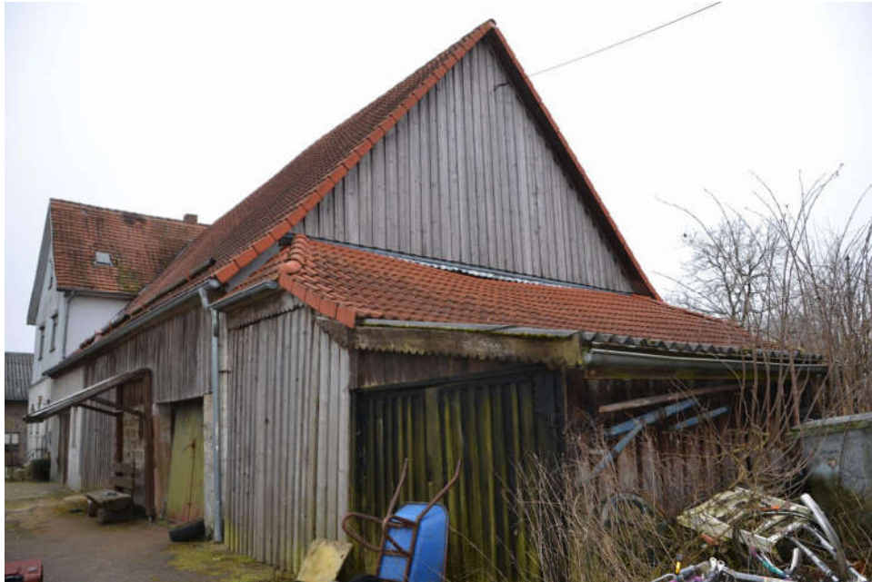
Bild 9: Nordwestansicht Wohnhaus mit Scheunenanbau
