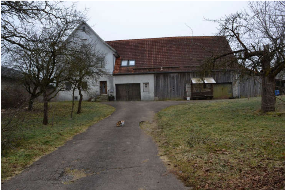
Bild 3: Nordansicht mit Privatzufahrt (Schäden erkennbar)
