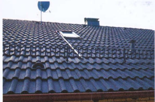
Bild 8: später beschichtete Dachdeckung
