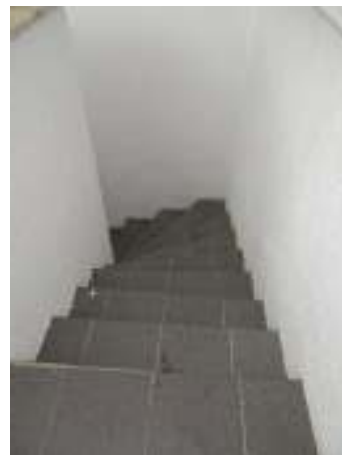
Treppenabgang ins UG
