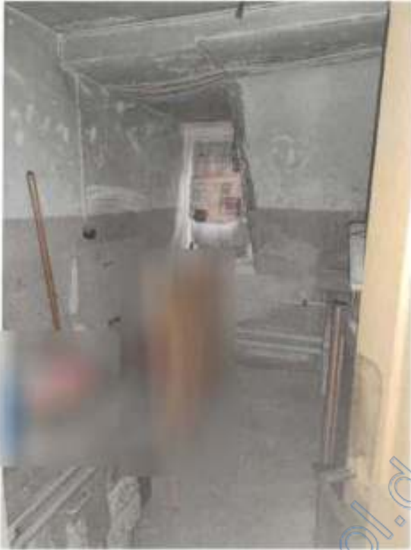
Zimmer Dachgeschoss (nicht ausgebaut)
