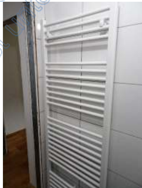
Fehlende Verfugung hinter HK
