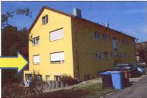
Blick von Nordosten
