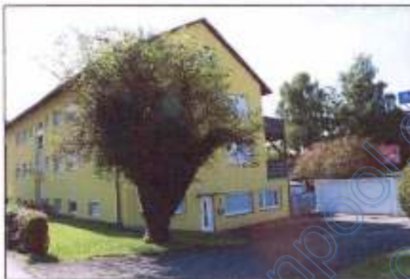
Blick von Nordwesten
