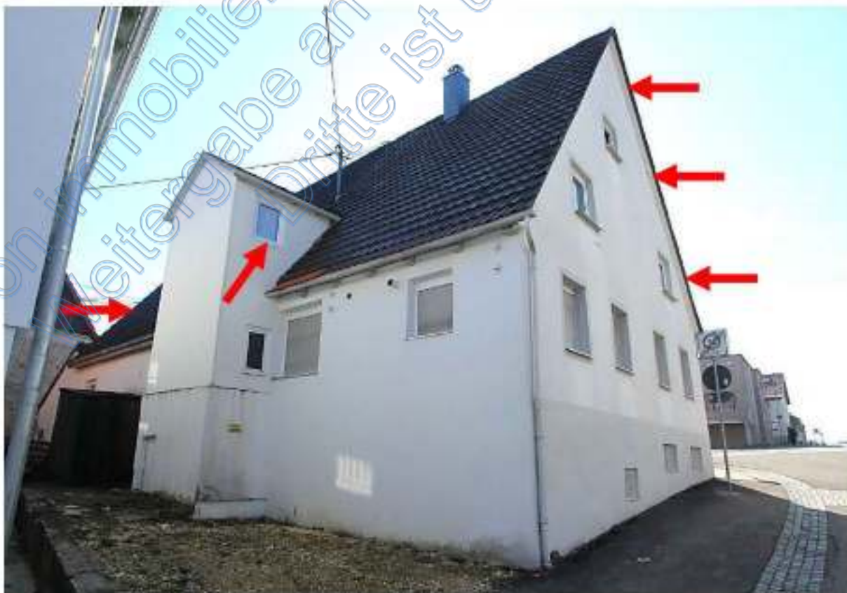
Nordseite Dreifamilienhaus, rote Pfeile Wohnung Nr. 2 im 1. + 2. DG, Bühne im Spitz
