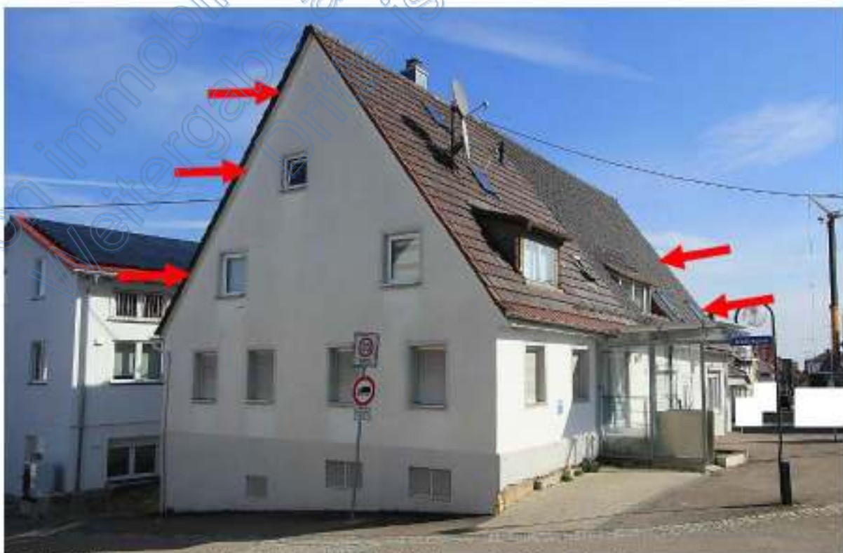
Dreifamilienhaus von Südwesten, rote Pfeile Wohnung ATP Nr. 2 im DG
