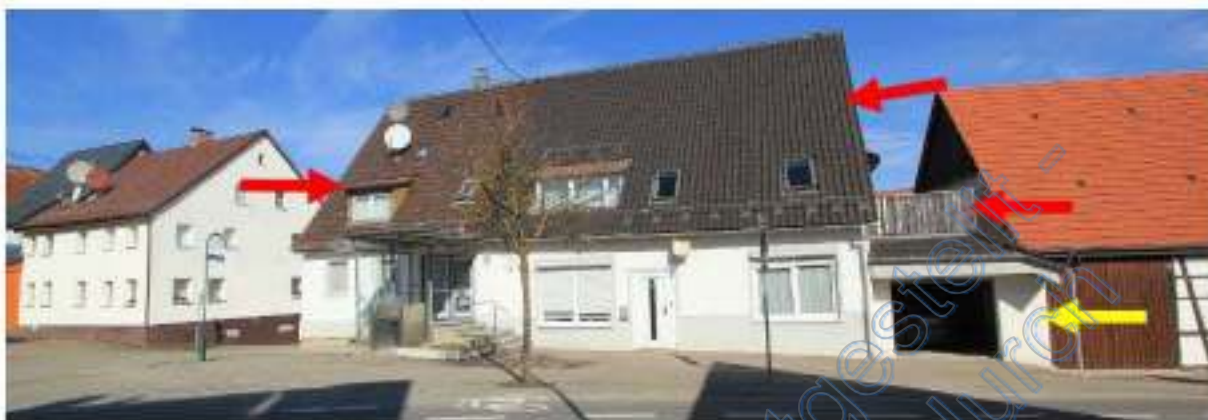
Blick von Süden zum 3-Familienhaus, rote Pfeile Wohnung Nr. 2 im 1. + 2. DG, gelb Garage 2
