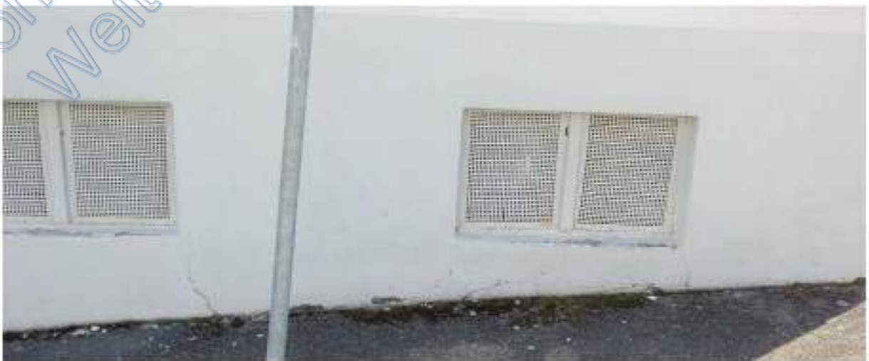
Kellerfenster im westlichen UG
