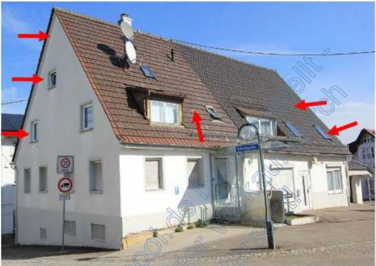
Dreifamilienhaus von Südwesten, rote Pfeile Wohnung ATP Nr. 2 im DG, oben Bühne im Spitz
