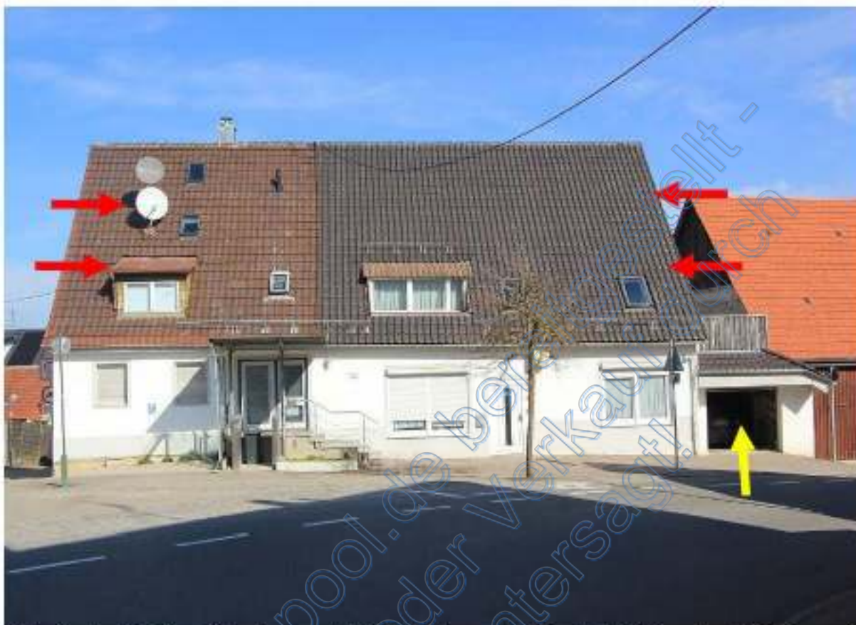
Südseite Dreifamilien-Wohnhaus, rote Pfeile Wohnung Nr. 2 im 1. + 2. DG, gelber Pfeil Garage 2
