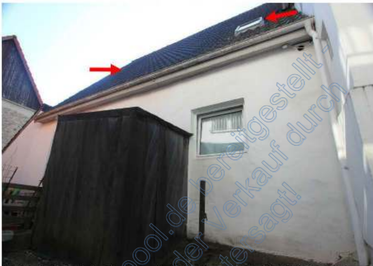
Ostliche Nordseite Dreifamilienhaus, roter Pfeil rechts Dachfenster Küche Nr. 2 im 1. DG
