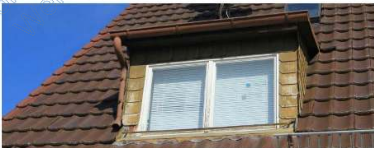
Oben Dachgaube vom Esszimmer, unten Gaube vom Schlafzimmer im 1. DG von ATP Nr. 2
