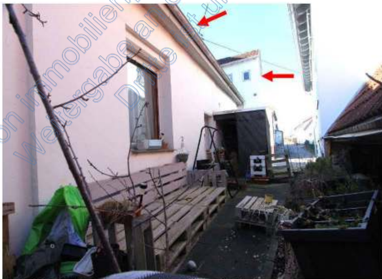
Nordseite Dreifamilienhaus von Osten, links Wohnung ATP Nr. 3
