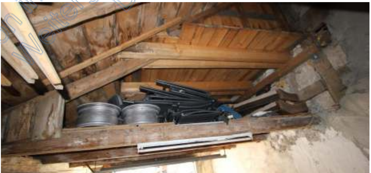
Vorderer Teil der Garage mit Dach
