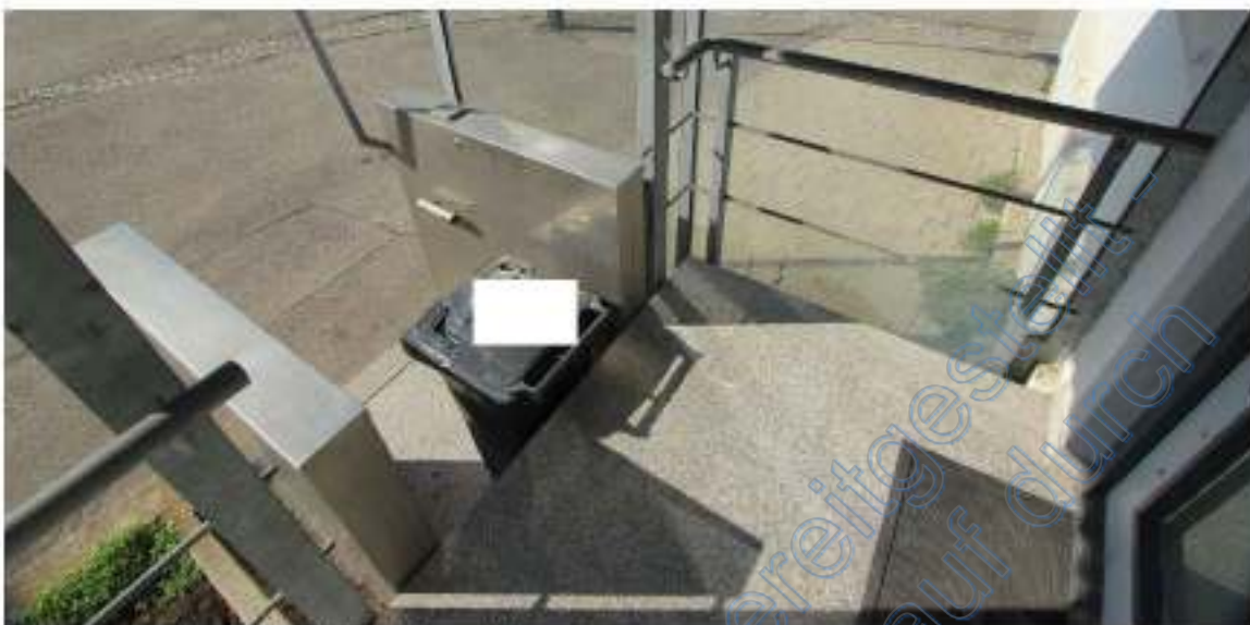
Eingangspodest mit Behindertenaufzug
