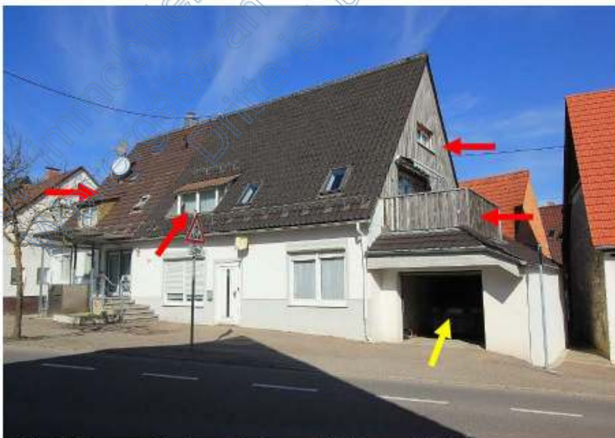
Dreifamilienhaus von Südosten, rechts Garage mit Balkon von ATP Nr. 2
