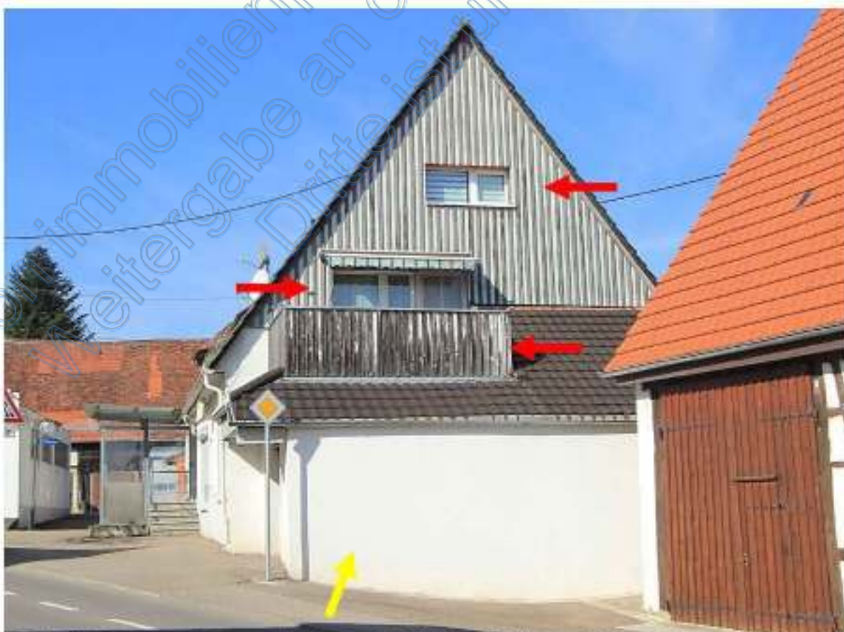
Dreifamilienhaus von Osten, gelb Garage ATP Nr. 2 mit Balkon auf dem Dach, rot Wohnung 2
