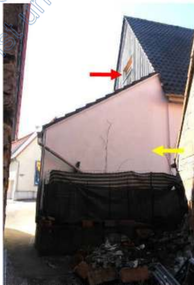
Garage (gelb) von Norden, rot ATP Nr. 2 im 2. DG
