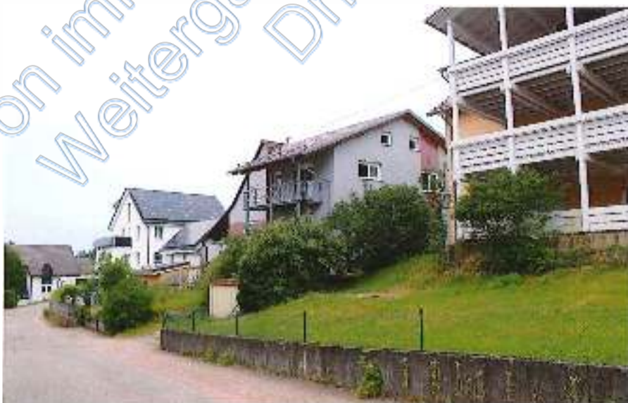
Foto 5: Blick auf das Wohnhaus von der Straße "Am Waldsaum" aus (Süden)
