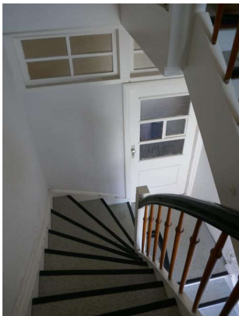
Bild 4: Treppenhaus mit Wohnungseingangstür
