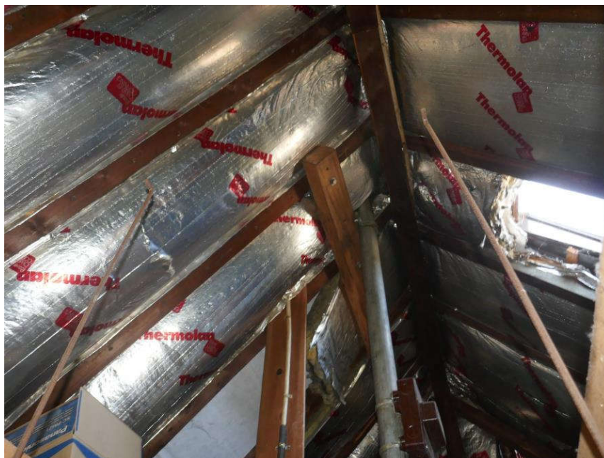
Bild 8: Dachspitz mit Innendämmung
