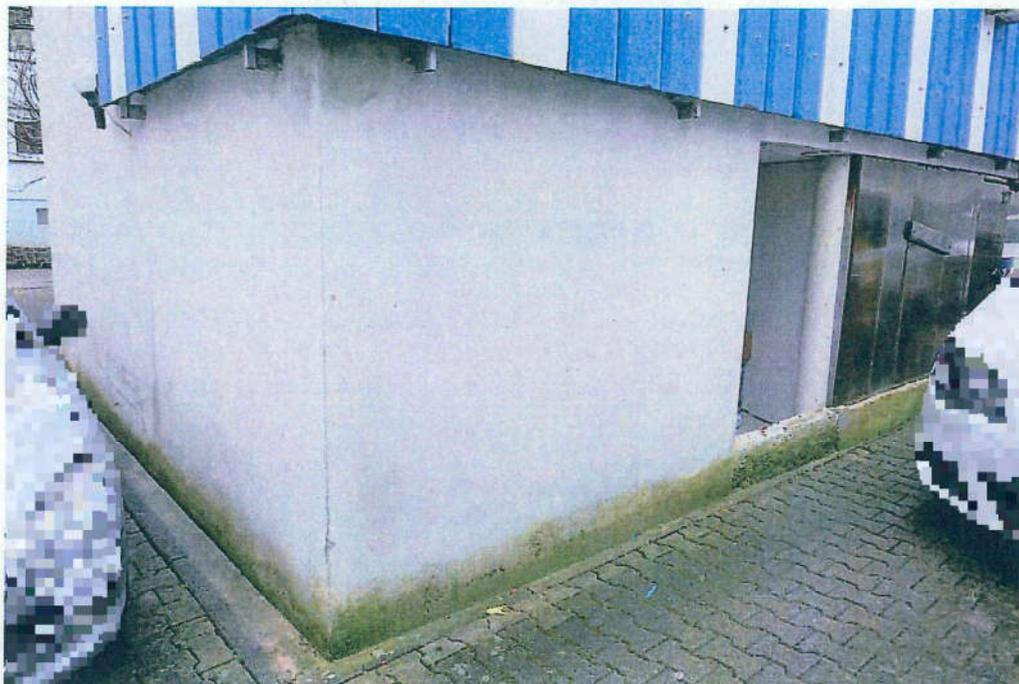
Um unteren Bereich des Wohnhausanbaus sind Feuchtigkeitsschäden sichtbar.
