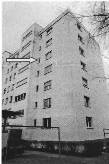
Blick auf das Wohnhaus Nr. 12 von Nordwesten. Der gelbe Pfeil zeigt das WC-Fenster. Rechts daneben befinden sich das Küchenfenster und um die Ecke das Kinderzimmerfenster.
