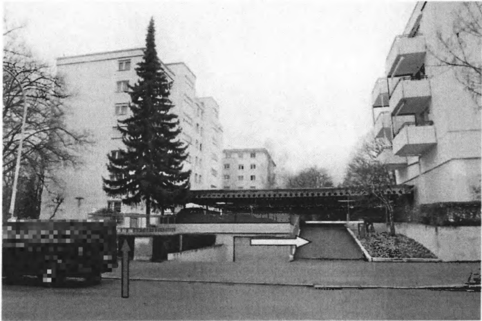
Blick auf einen Teil der Häusergruppen auf dem Flst. Nr. 2087 von Osten aus. Der gelbe Pfeil zeigt auf die Zufahrt zum Parkdeck, der rote Pfeil auf den Mülltonnenstandort.
