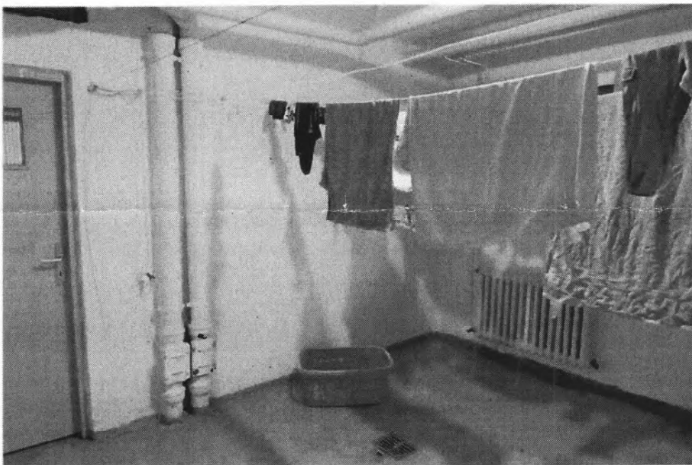
Im 1. Untergeschoss befindet sich ein Trockenraum als Gemeinschaftsraum.
