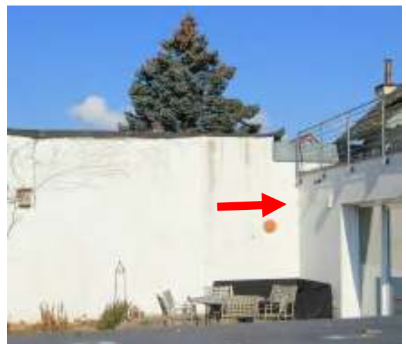
Anschluss vorderer Anbau ans Nachbarhaus
