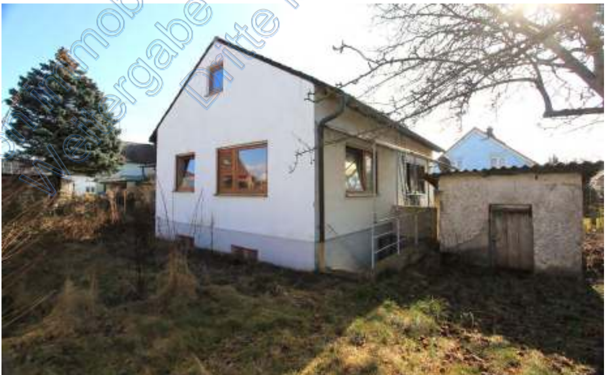
Hinteres Wohnhaus mit Kelleraußentreppe und altem Hühnerstall von Westen
