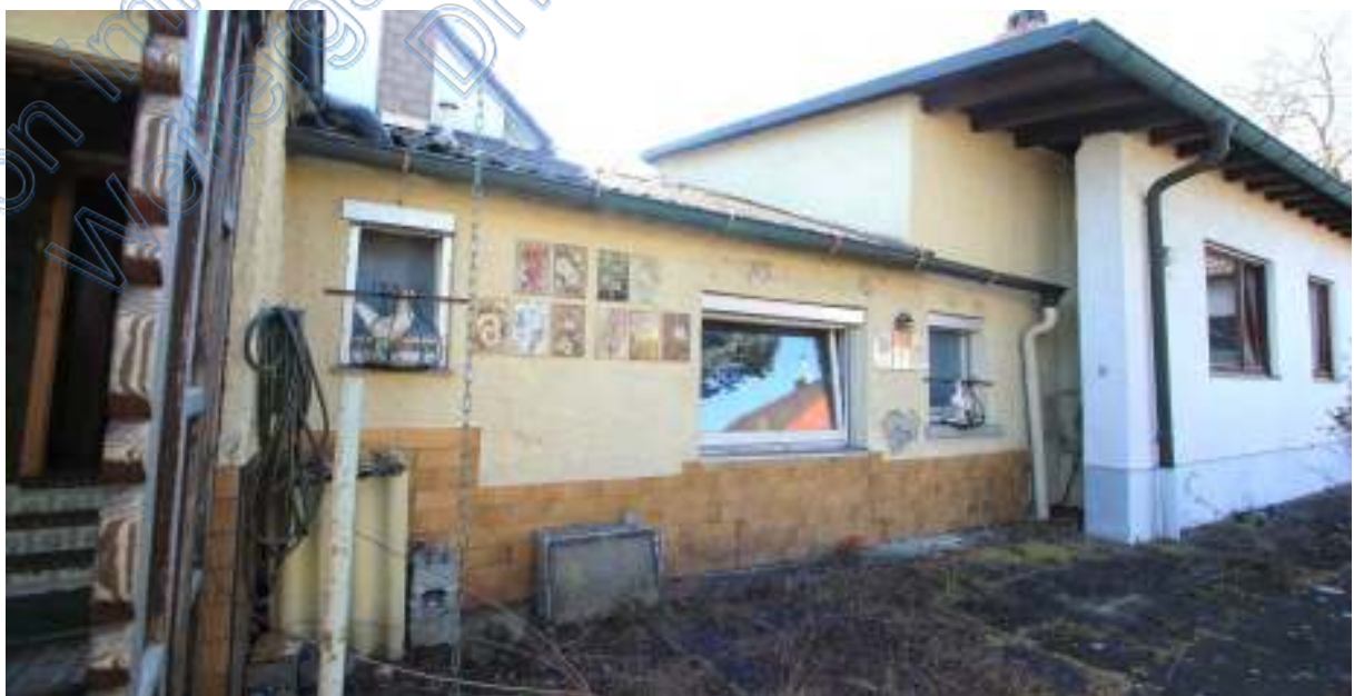
Nordwestseite Anbau Vordergebäude, rechts Anbau Hintergebäude
