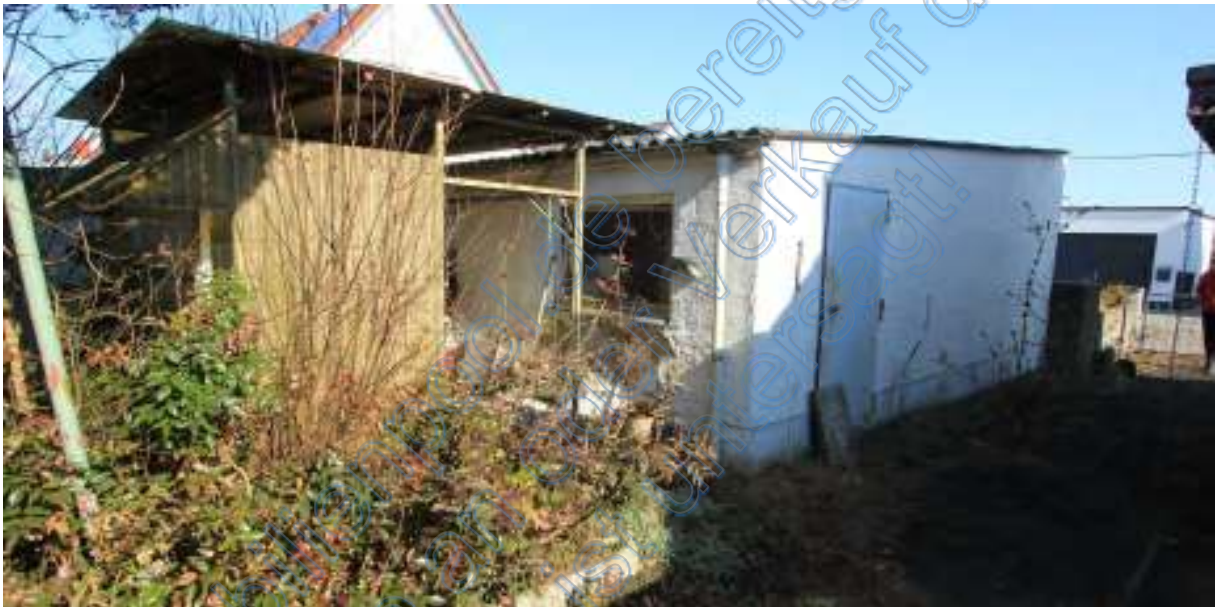
Doppelgarage von Süden, links alter Wellpolyesterunterstand
