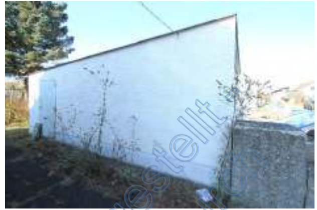
Seitenwand der Doppelgarage
