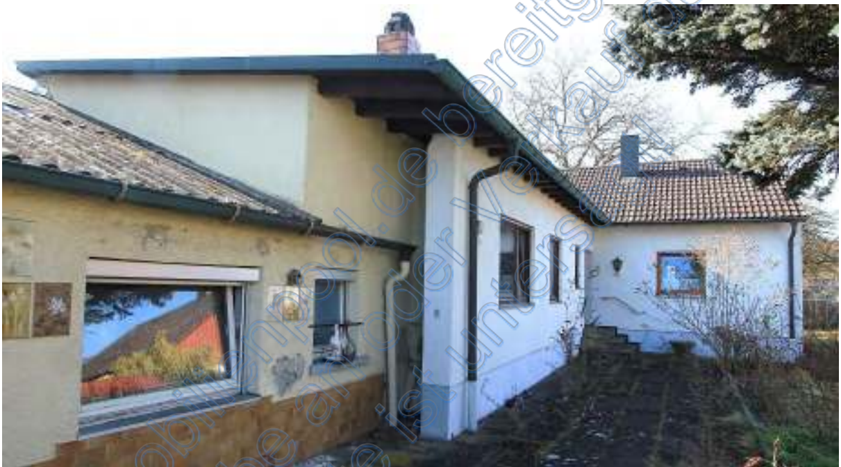
Anbau und Satteldachteil Hintergebäude von Nordosten
