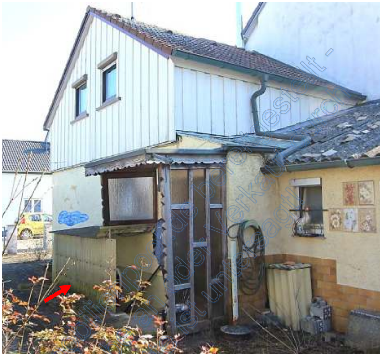
Vordergebäude Satteldachteil von Westen mit Zugang, Pfeil überdeckte Kelleraußentreppe
