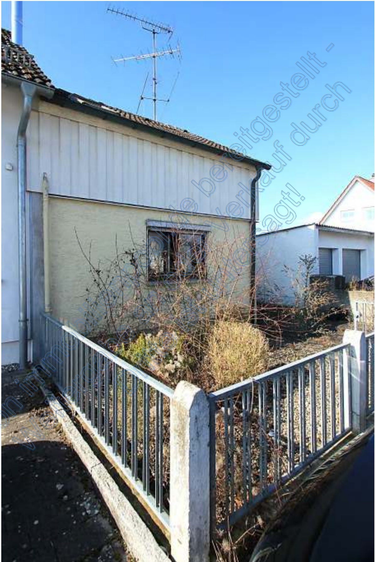
Nordostseite Vordergebäude und Vorgarten
