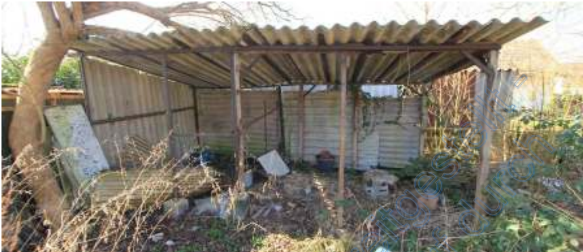
Unterstellschuppen im südlichen Eckbereich
