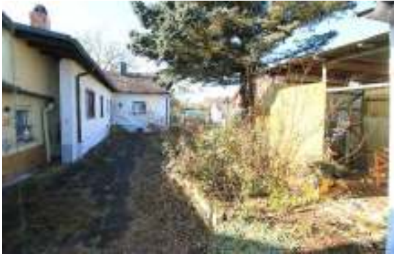
Blick nach Südwesten, rechts Unterstand
