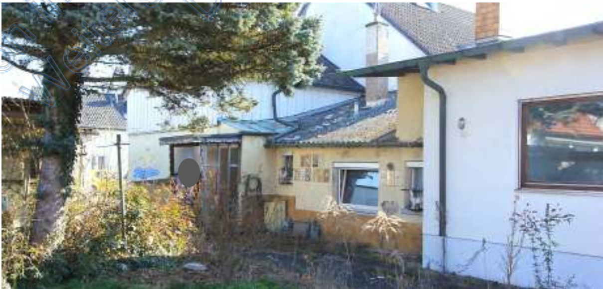
Vordergebäude mit Anbau von Westen, rechts Anbau Hintergebäude
