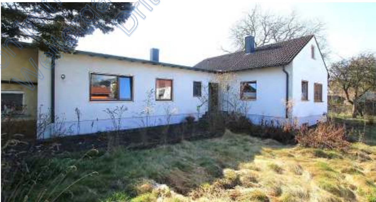
Wohnhaus Hintergebäude mit Anbau und Satteldachteil von Norden
