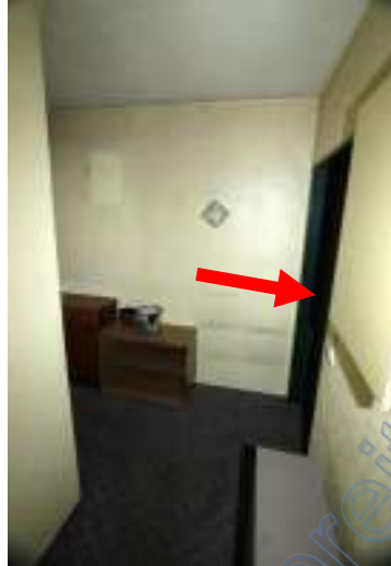
Flur EG, Pfeil Kellertreppe
