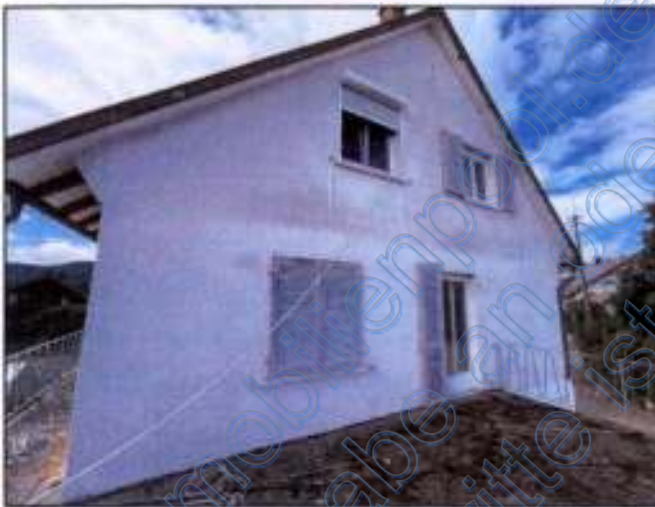
Terrasse über Anbau Nordseite.
