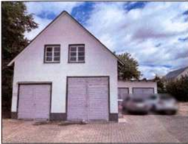
Lagergebäude, Ansicht von Süden.
