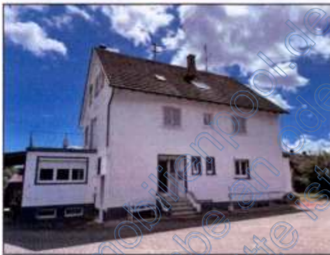
Ansicht aus Nord-Ost.
