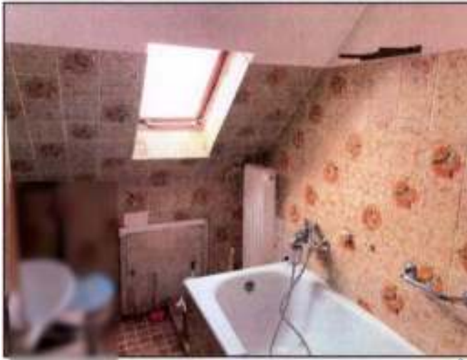
Altes Bad im DG.
