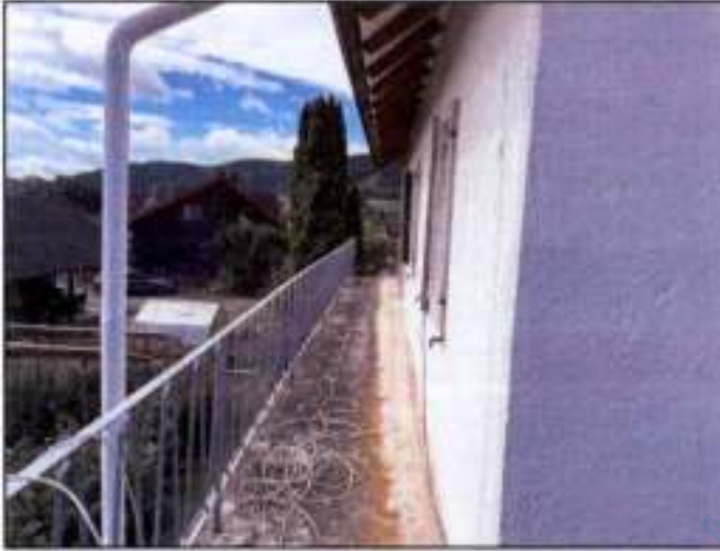
Balkon Ostseite 1. OG Wohnhaus.
