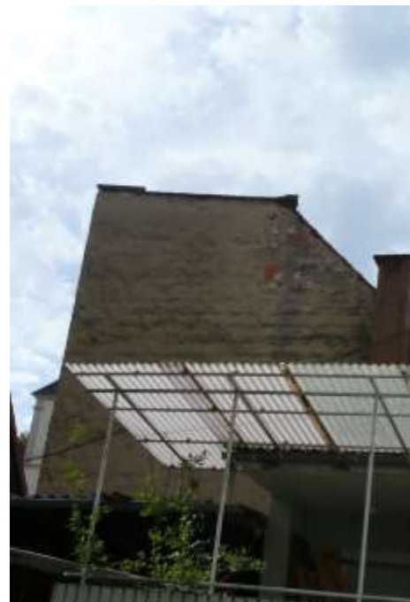
Nordfassade der Scheune
