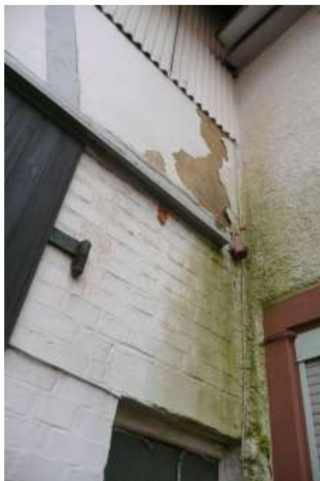
Feuchtigkeitsschäden Fassade, Übergang Wohnhaus zur Scheune
