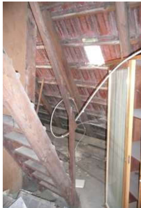
Räumlichkeiten Dachgeschoss Treppe zum Dachspitz
