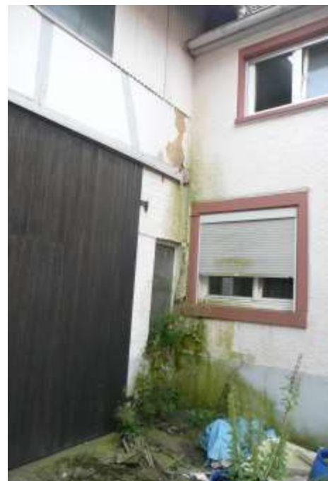
Feuchtigkeitsschäden Fassade, Übergang Wohnhaus zur Scheune
