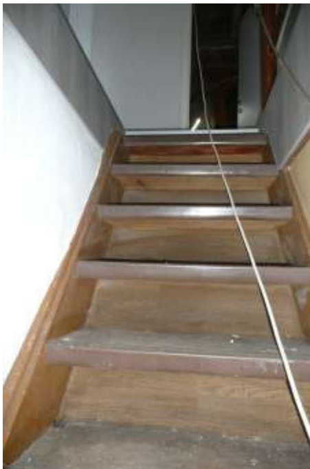
Aufgangstreppe zum Dachgeschoss
