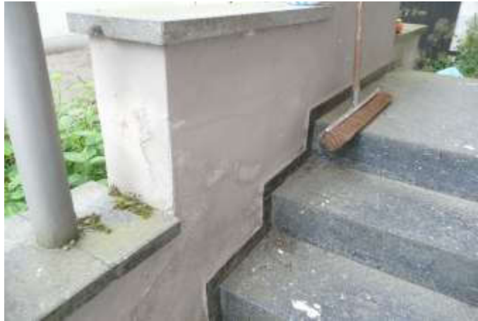
Feuchtigkeitsschäden Hauseingangstreppe
