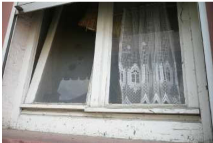
Feuchtigkeitsschäden Fassade, Übergang Wohnhaus zur Scheune
