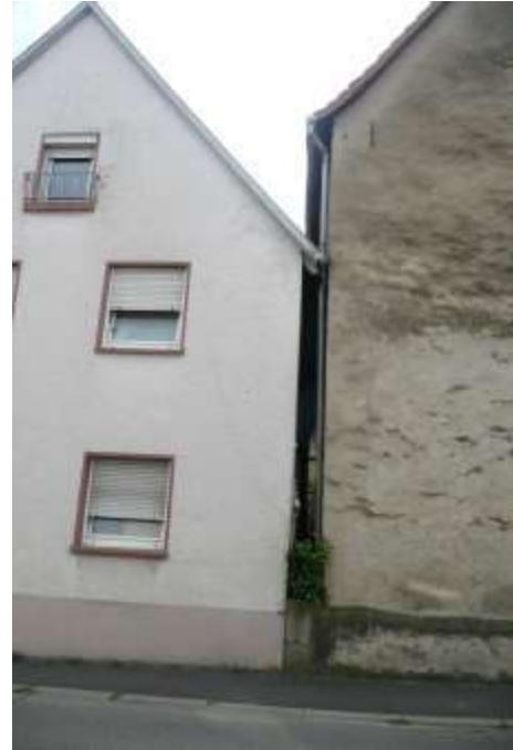
Traufgasse an der Südseite
