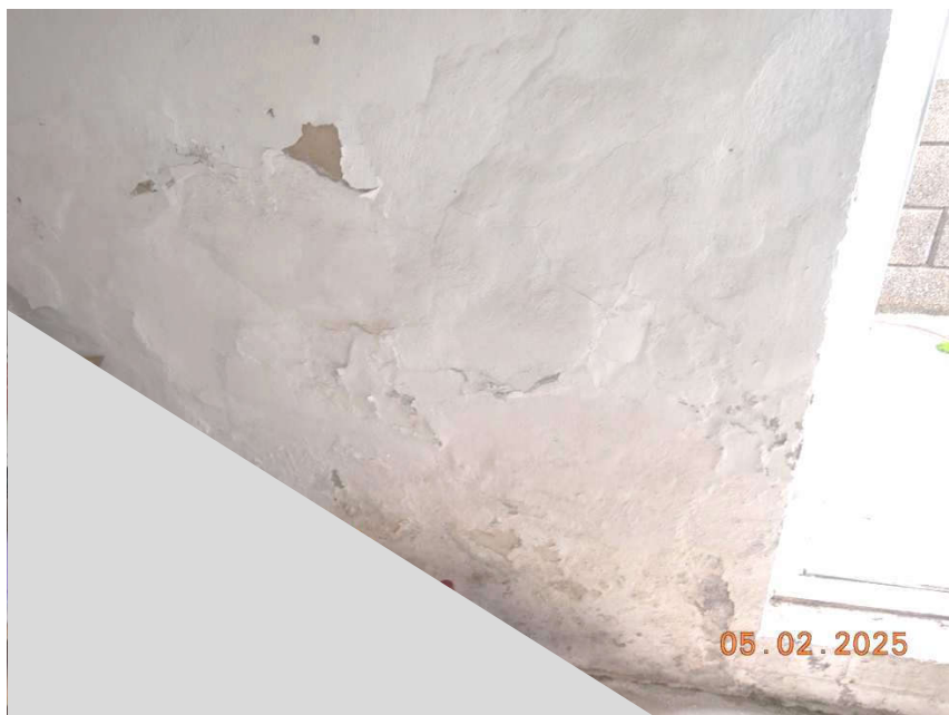
Abb. 6: Feuchtigkeitsschäden an der südseitigen Kelleraußenwand
