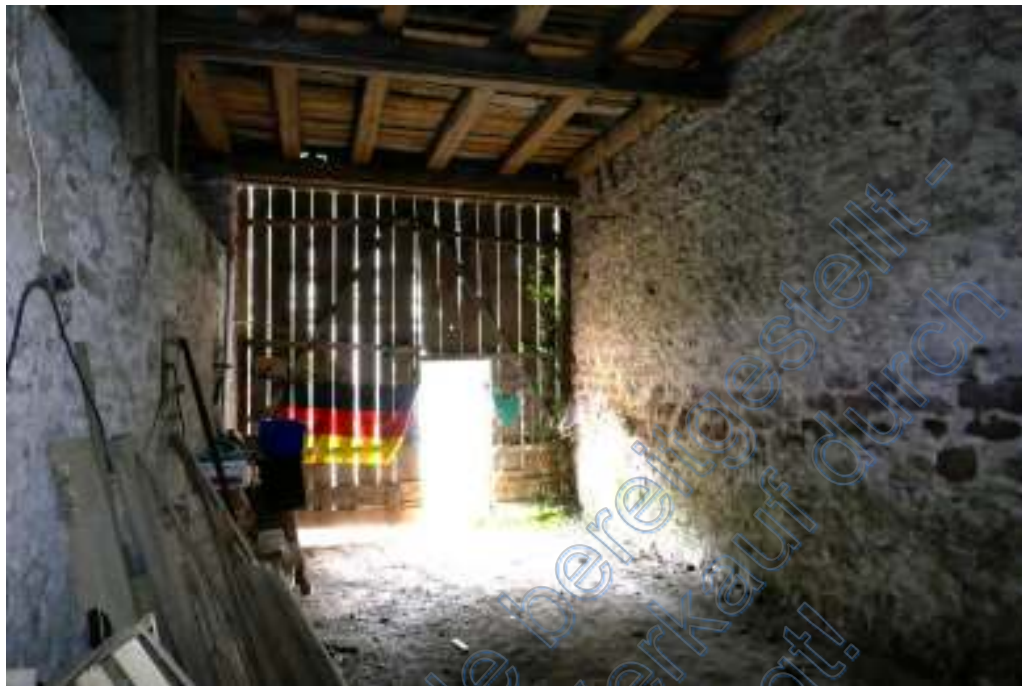
Blick in den Scheunenbereich Richtung Eingang.
