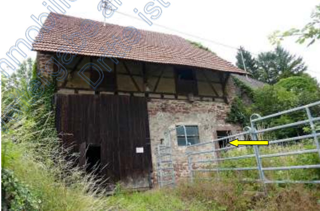
Blick auf das Scheunengebäude. Der gelbe Pfeil zeigt auf den Zugang zum Stallbereich.
