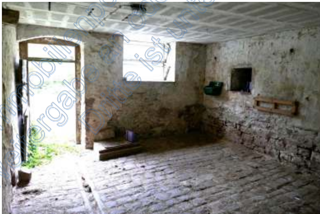
Blick in den Stallbereich des Scheunengebäudes.
