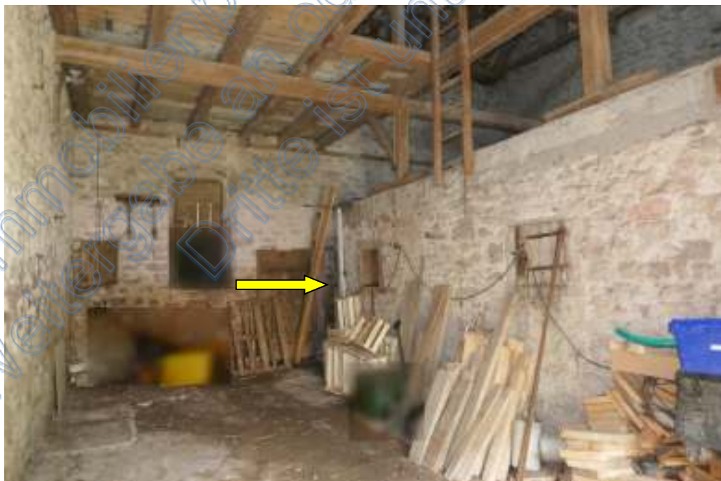
Vom Scheunenbereich besteht ein Zugang zum Lagerraum (gelber Pfeil). Der obere Teil der Scheune konnte nicht besichtigt werden.
