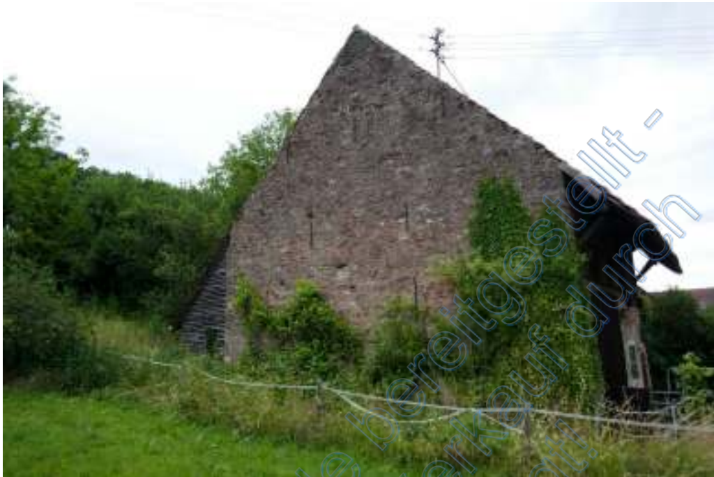
Seitenansicht des Scheunengebäudes von Südwesten.
