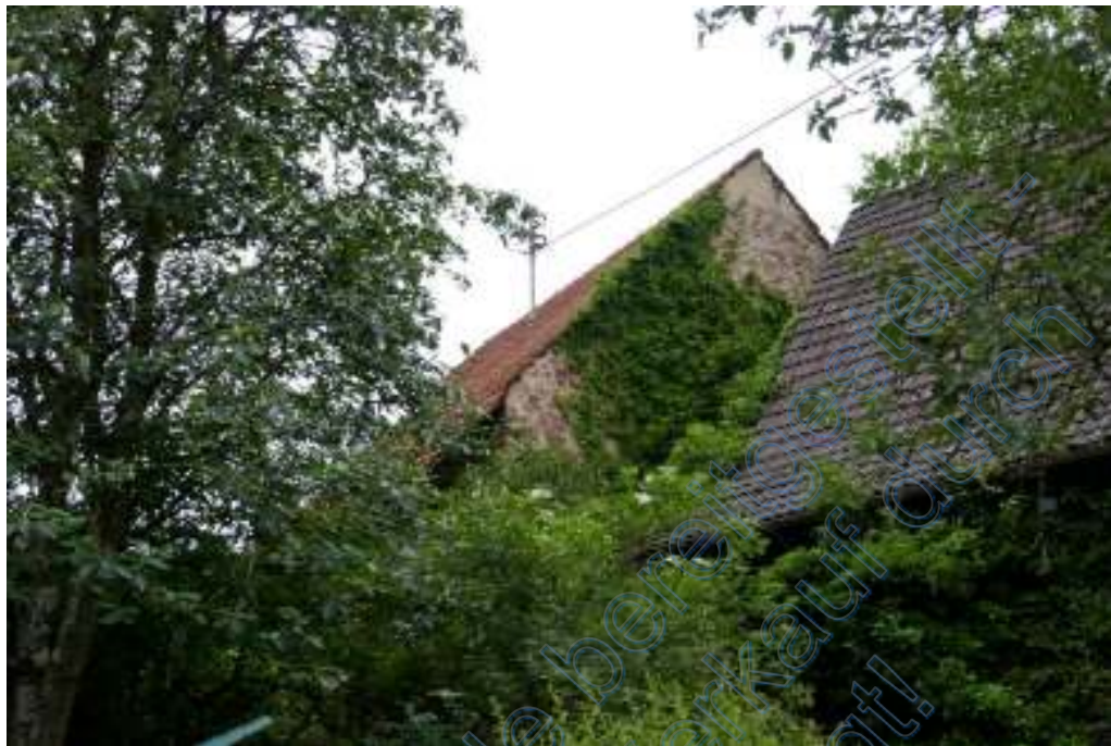
Teilansicht der Scheune von Osten
