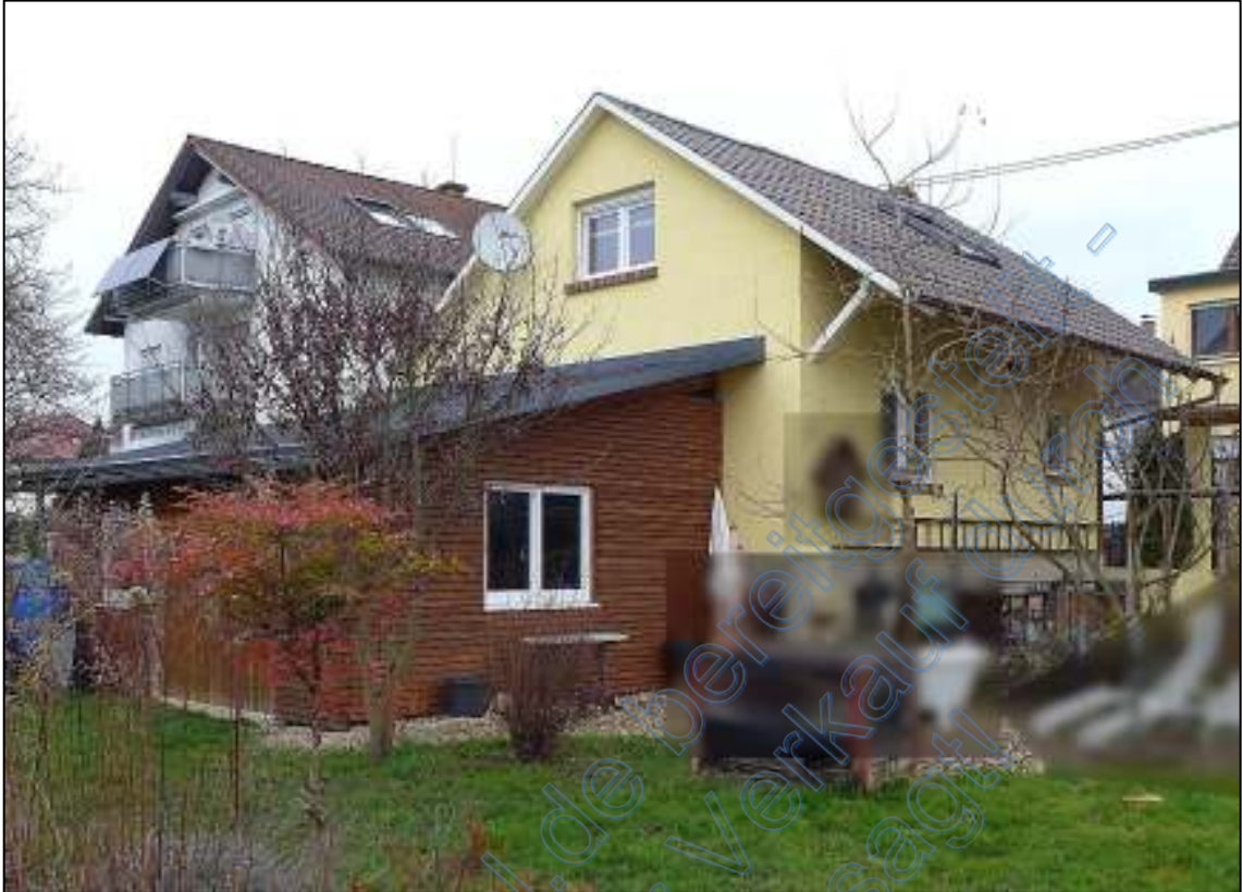
Bild 21 – Garagengebäude mit rückseitigem Werkstattanbau
