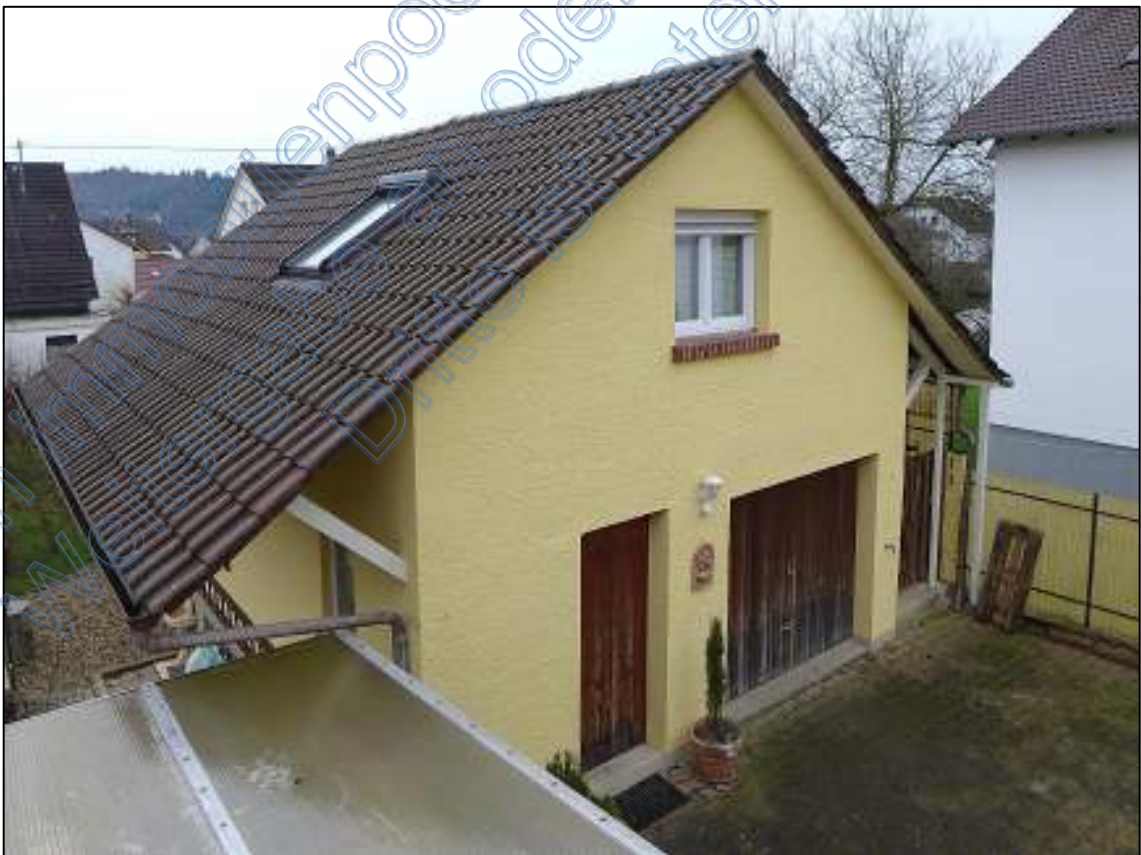
Bild 18 – Blick vom Balkon auf das Garagengebäude
