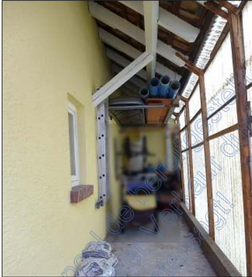
Bild 17 – Lager neben der Garage
