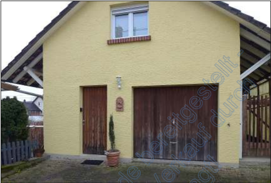
Bild 17 – Garage mit kleiner Wohnung im DG
