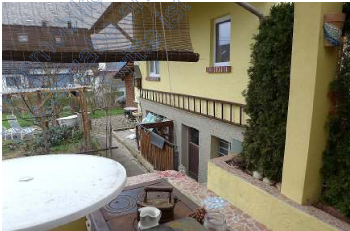
Bild 18 – Unterkellerung der Garage
