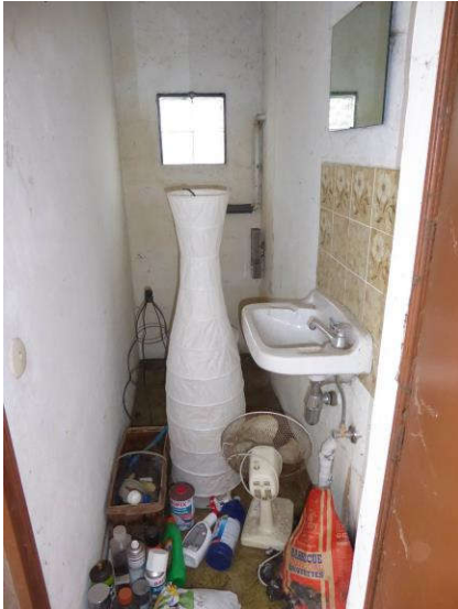
7. Außen-WC im Anbau (nicht nutzbar)
