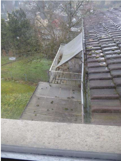
25. Blick auf Balkon
