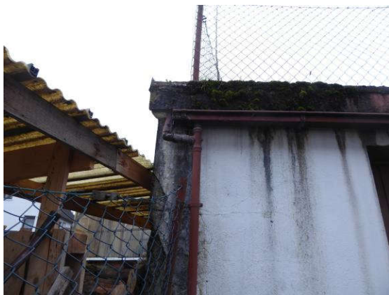
35. Feuchteschäden Garage
