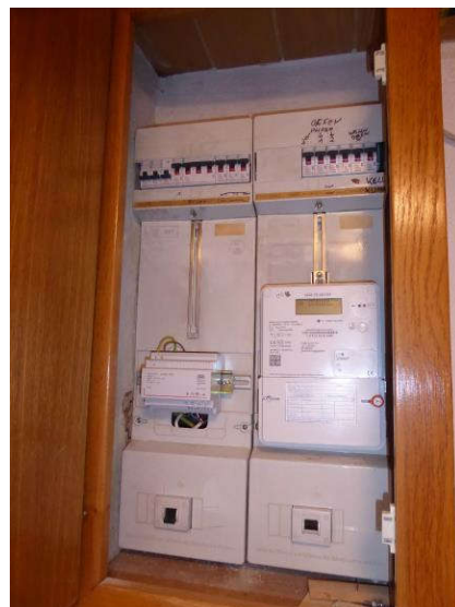
24. Sicherungskasten (erneuert)
