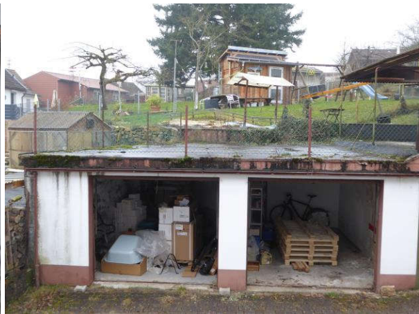
Straßenansicht von Osten
