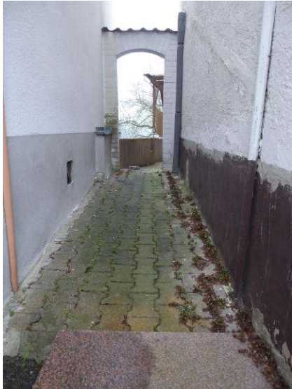
31. Nördlicher Zugang zur Terrasse
