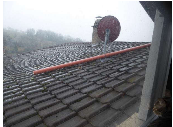
26. Blick auf Anbau (provisorisch verlegtes Regenrohr)
