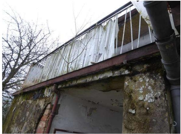
8. Starke Feuchteschäden – undichter Balkon
