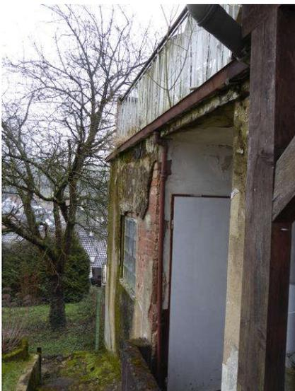
9. Starke Feuchteschäden – undichter Balkon
