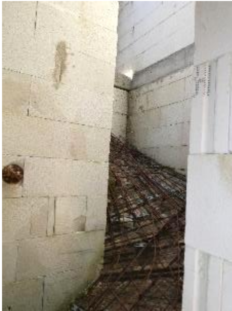
Unfertige Treppe EG-DG
