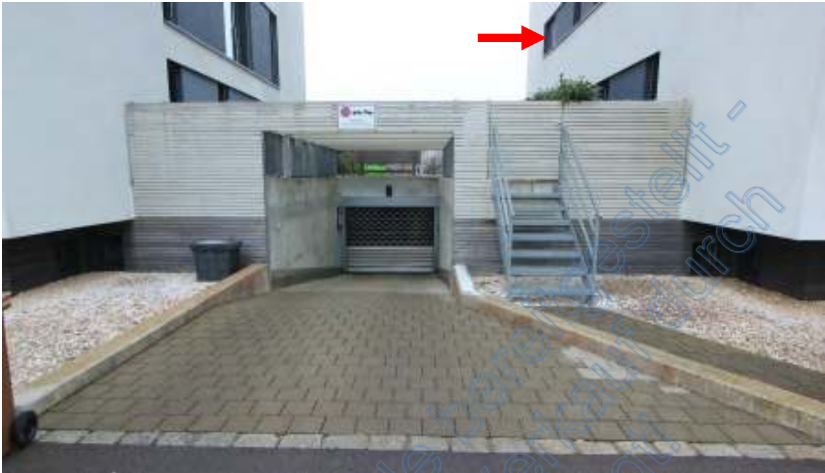
Tiefgaragenzufahrt zwischen Haus 1 und 2 im Westen, roter Pfeil Schlafzimmerfenster SE 2/4
