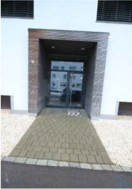
Eingang Otl-Aicher-Allee 8 im Westen,
