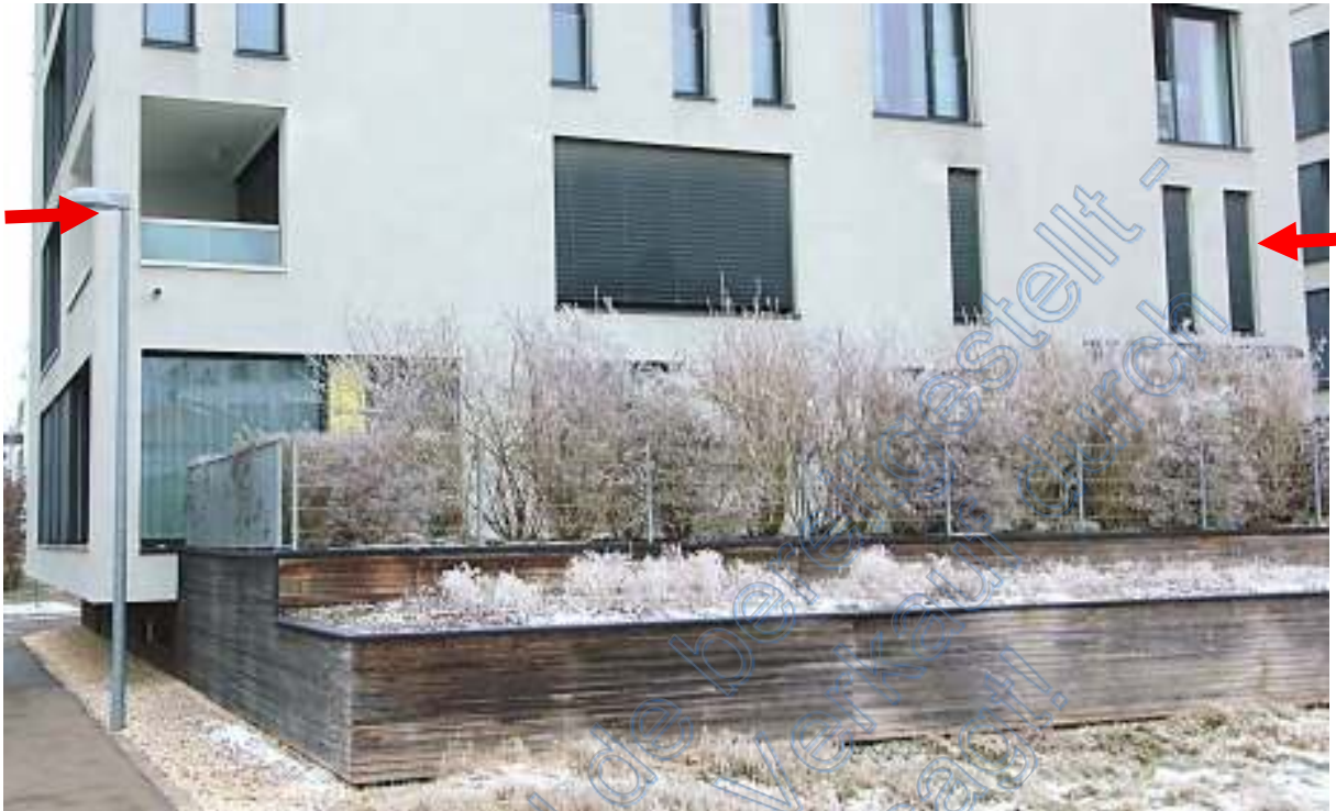
Von links Loggia, großes Fenster Essen/Küche, 1x schmales Badfenster, 2 Fenster Schlafen
