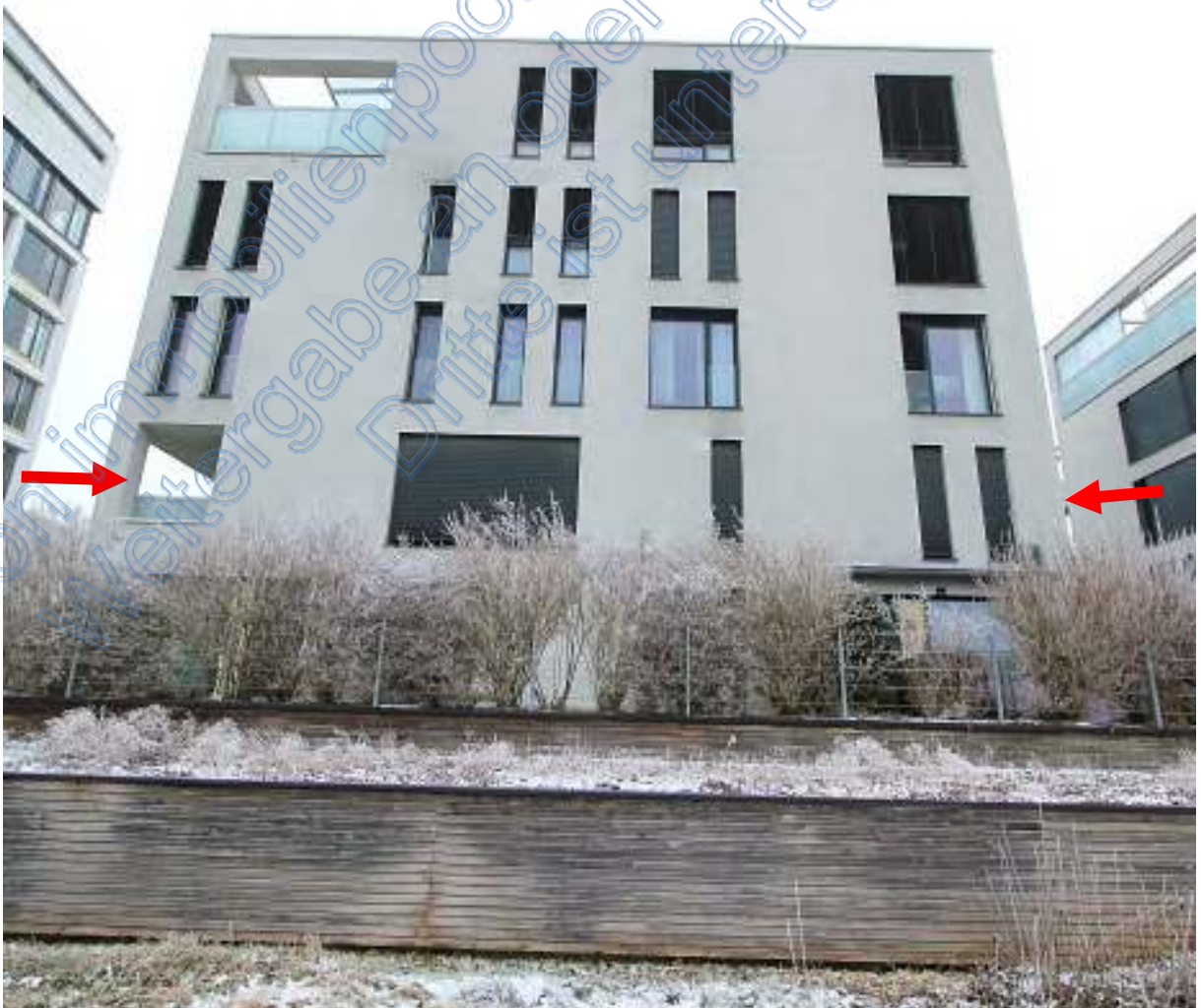
Ostseite Haus 2, unten Tiefgarage mit begrünem Dach, rot Wohnung ATP Nr. SE 4/2 im 1. OG
