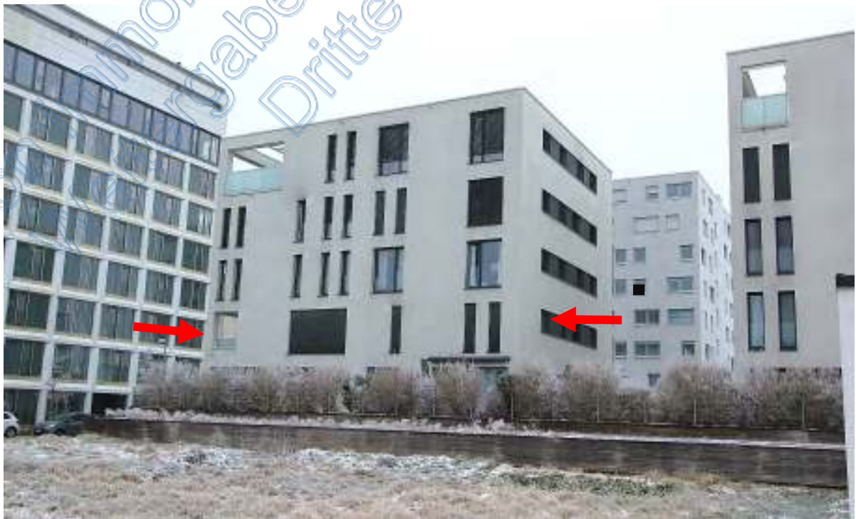
Blick von Nordosten, rote Pfeile Wohnung ATP Nr. SE 4/2 im 1. OG
