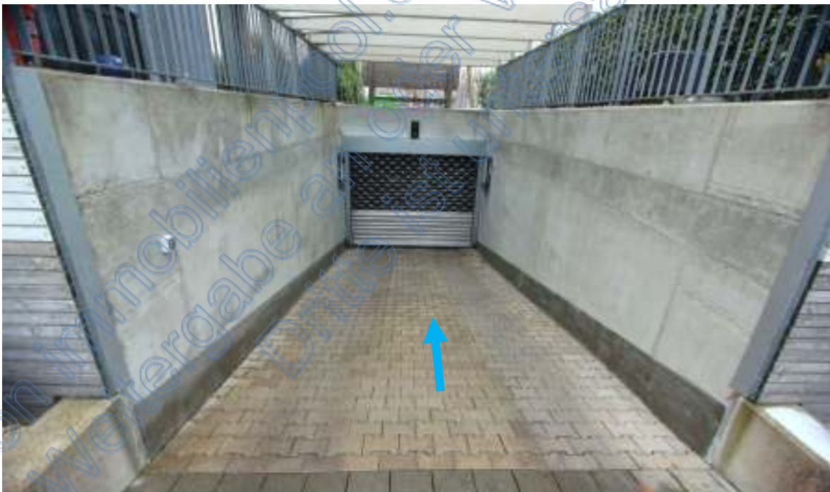
Tiefgaragenabfahrt zwischen Haus 1 und 2 im Westen
