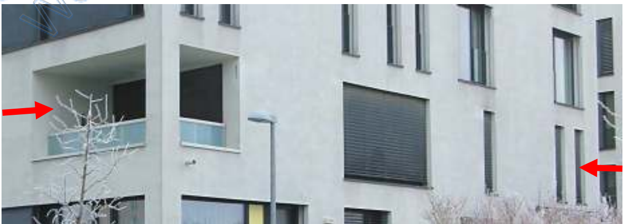
Rote Pfeile Loggia im Südosten und Wohnung ATP Nr. SE 4/2 im 1. OG nach Osten
