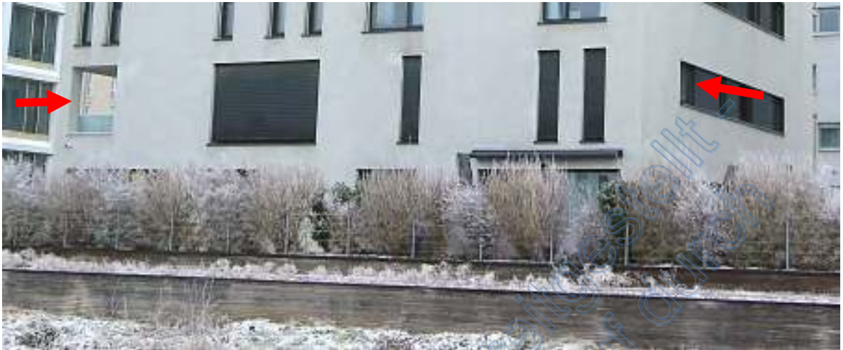
Ostseite Haus 2 Otl-Aicher-Allee 8, rote Pfeile Wohnung ATP Nr. SE 4/2 im 1. OG, von links Loggia, großes Fenster Essen/Küche, 1x schmales Badfenster, 3 Fenster Schlafen
