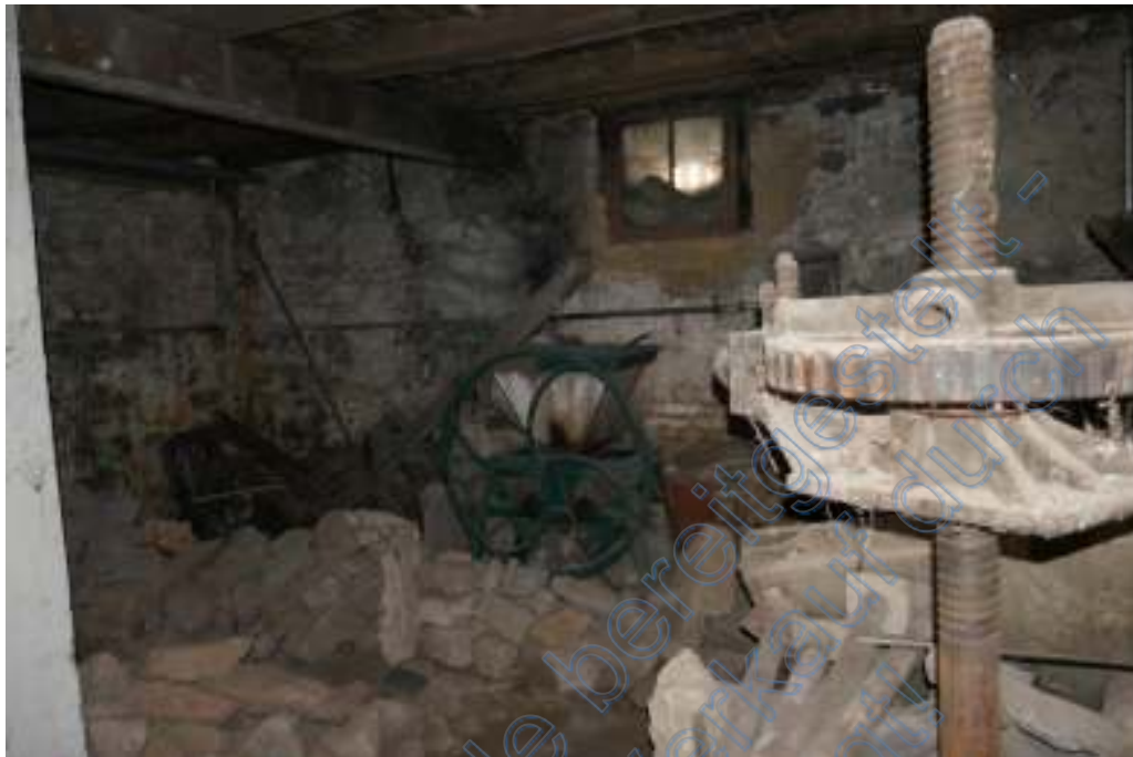
Sicht in einen Teil des Untergeschosses.
