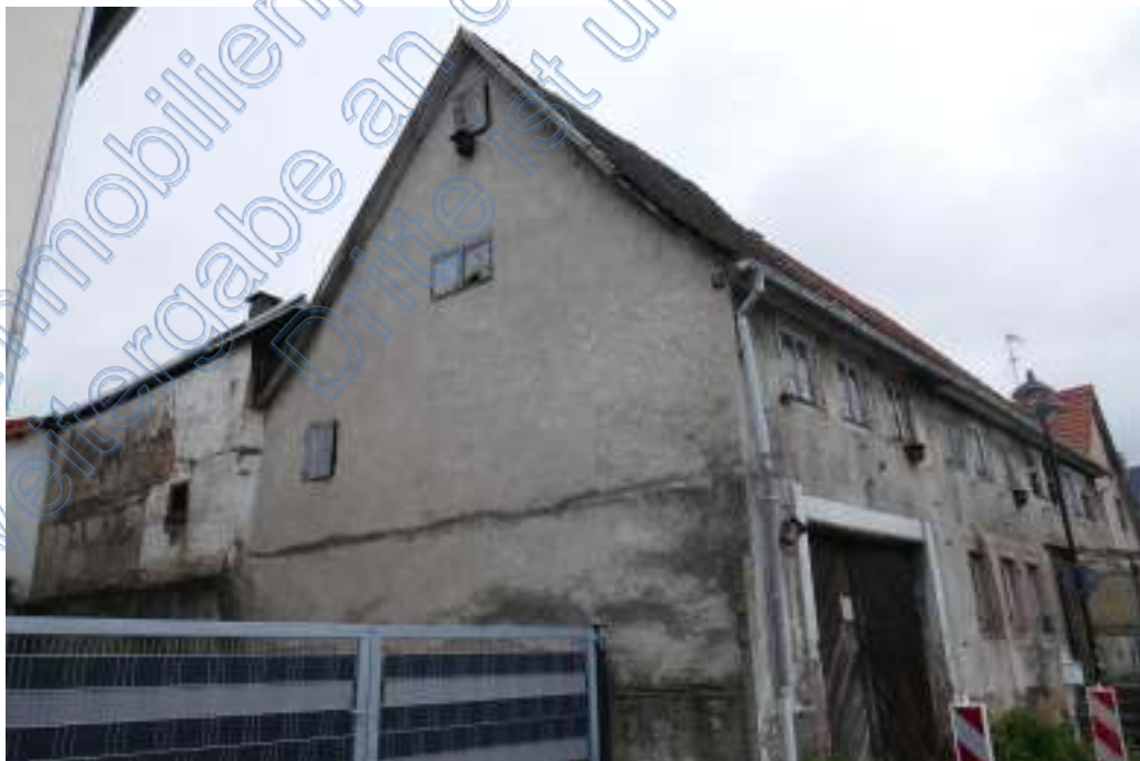
Ansicht von Südwesten mit angrenzendem westlichem Schuppengebäude.
