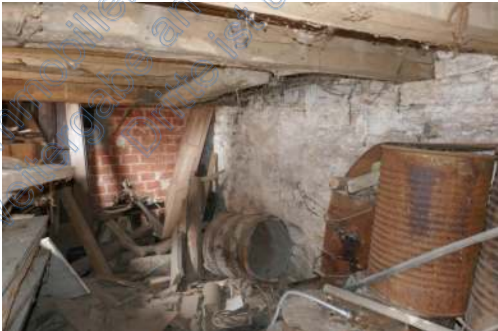
Sicht in einen Teil des Schuppengebäudes im Erdgeschoss.
