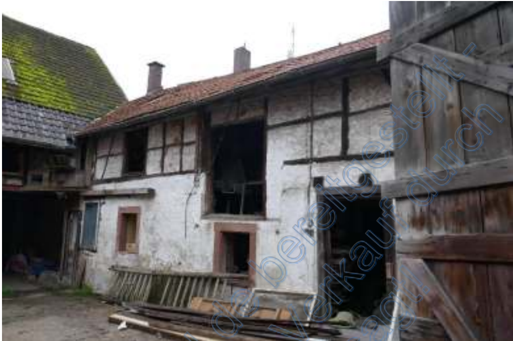
Blick auf das westliche Schuppengebäude.
