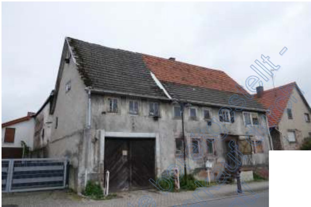
Blick auf das Wohnhaus mit angrenzendem Schuppengebäude. Am Dach wurden bereits Sicherungsmaßnahmen durchgeführt.
