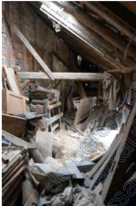
Blick in den oberen Teil des Schuppengebäudes.
