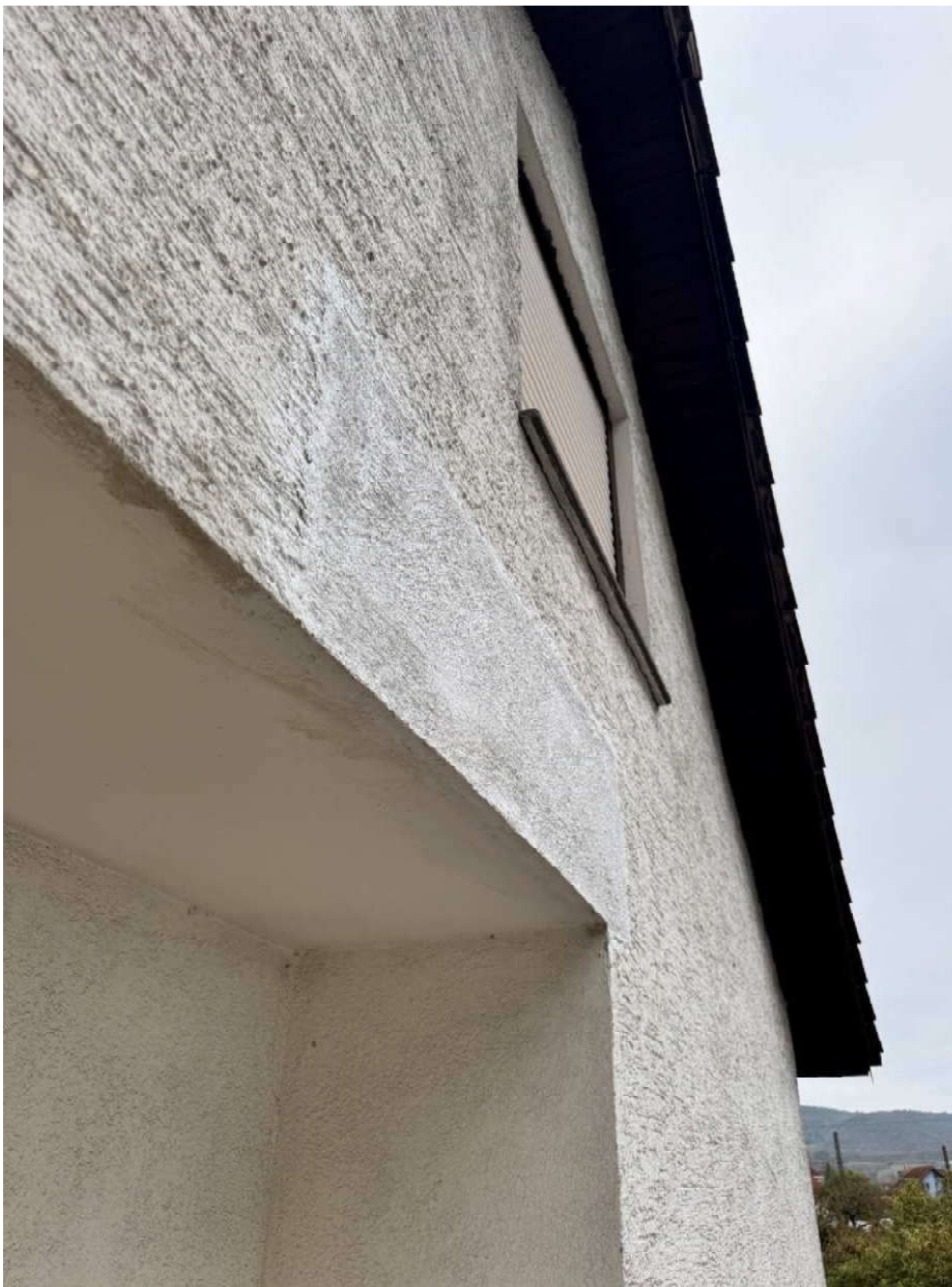
Abbildung 58 nachgearbeitete Fassade über Balkon
