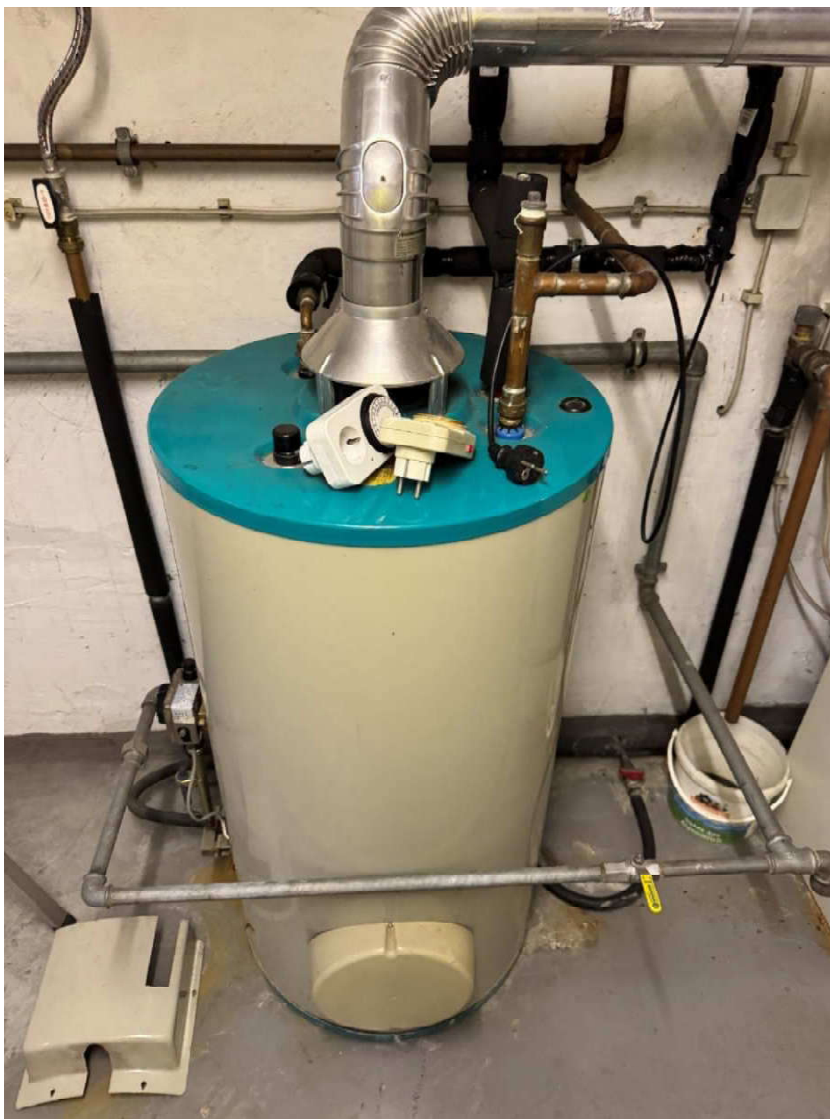
Abbildung 79 Detail Brauchwassererwärmung
