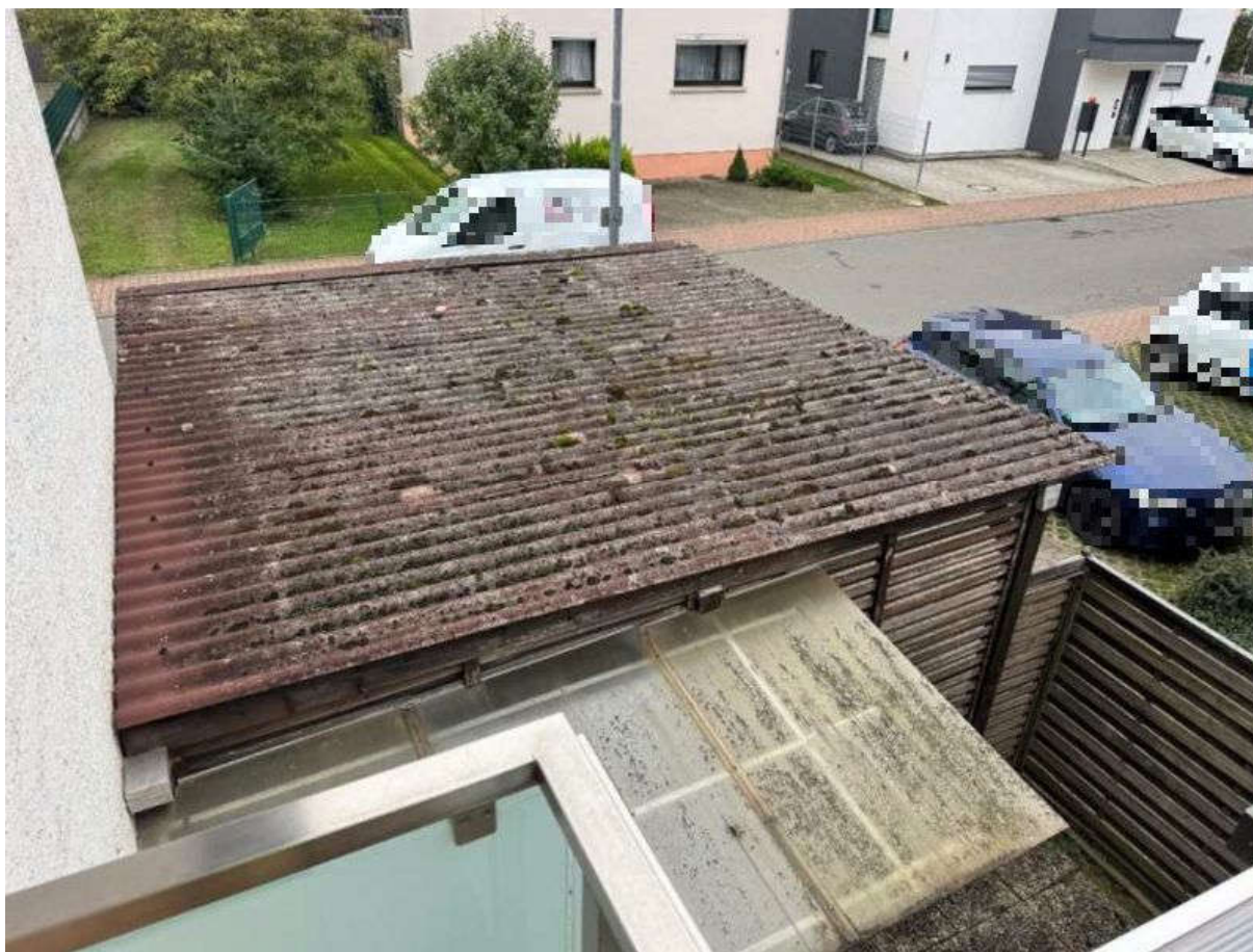
Abbildung 45 Carport, zur Straße
