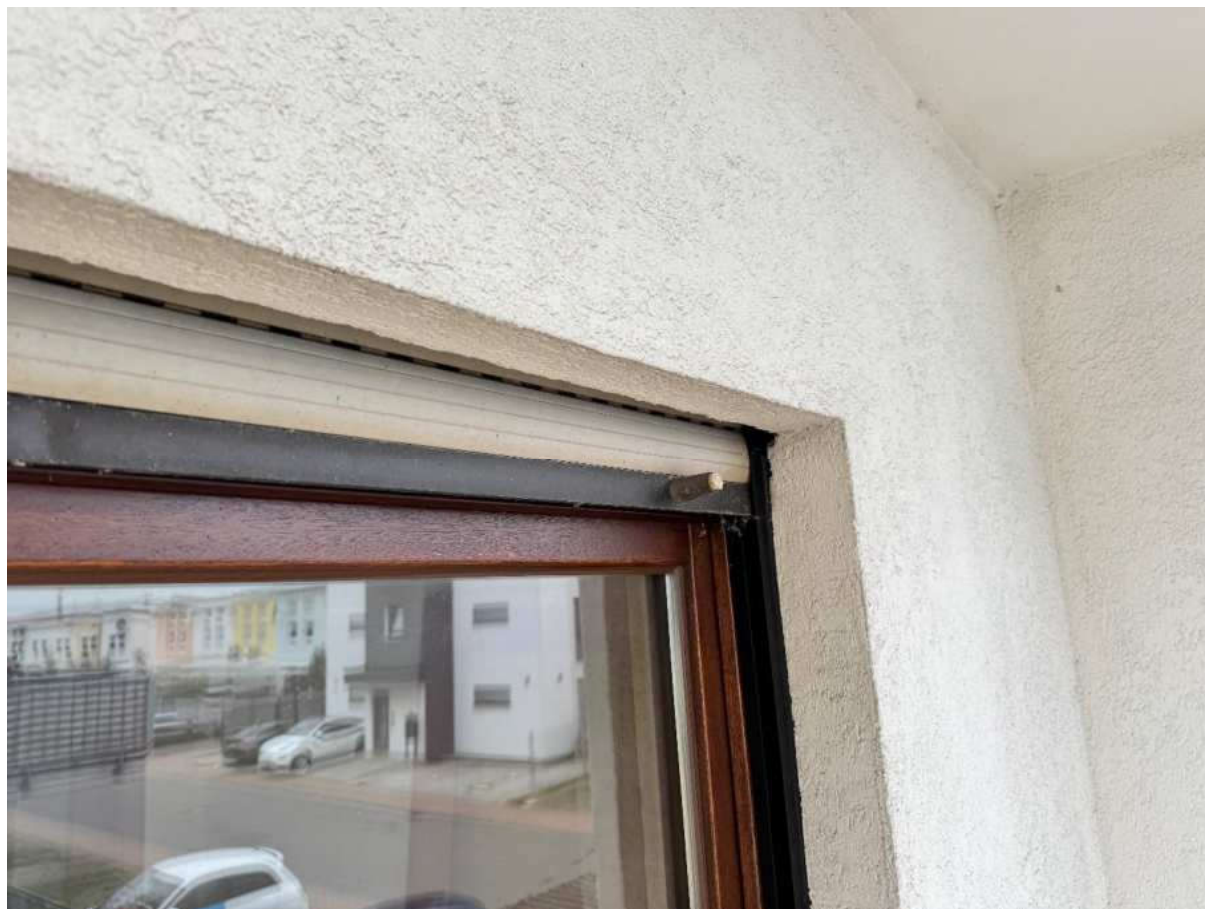
Abbildung 59 Detail Rollladenkasten, Behang
