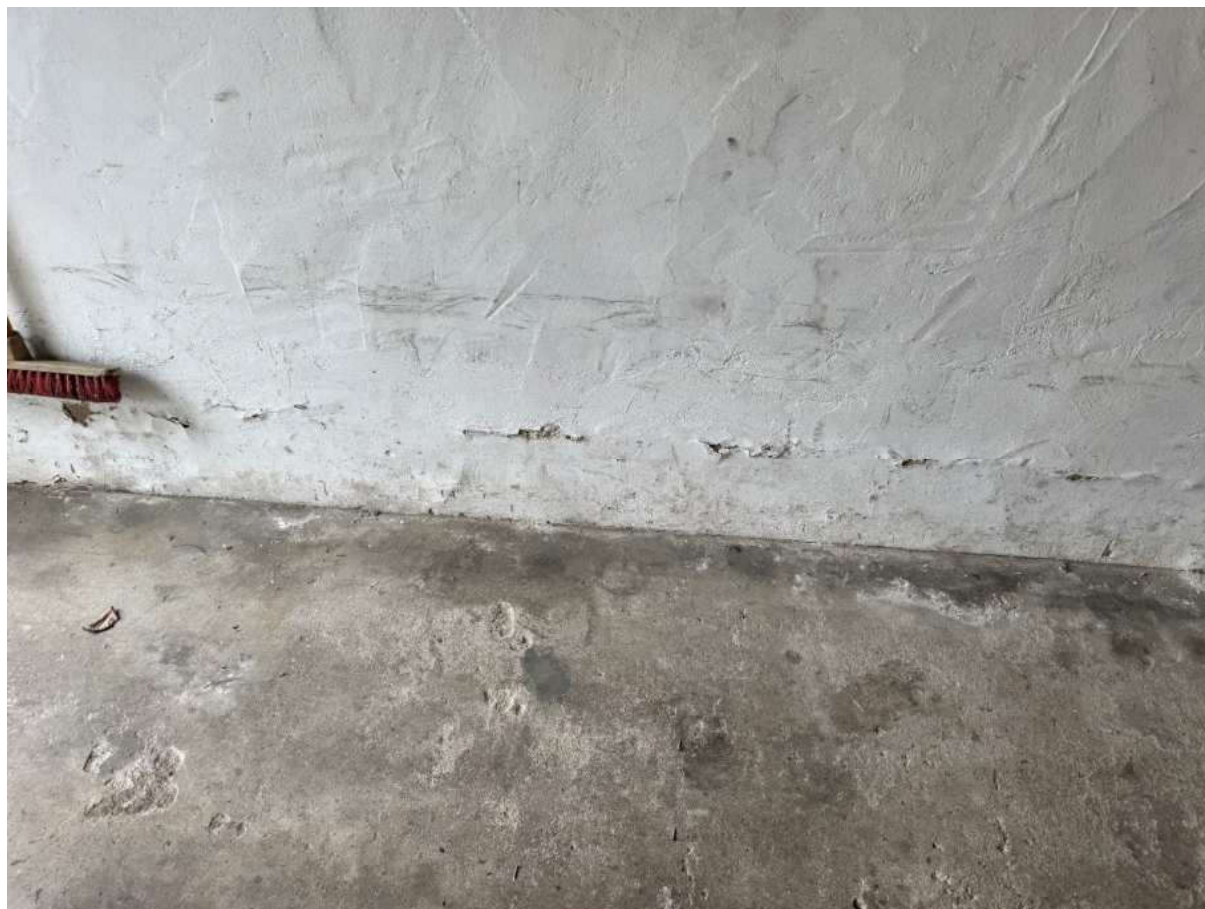
Abbildung 83 wie vor, Sockelbereich
