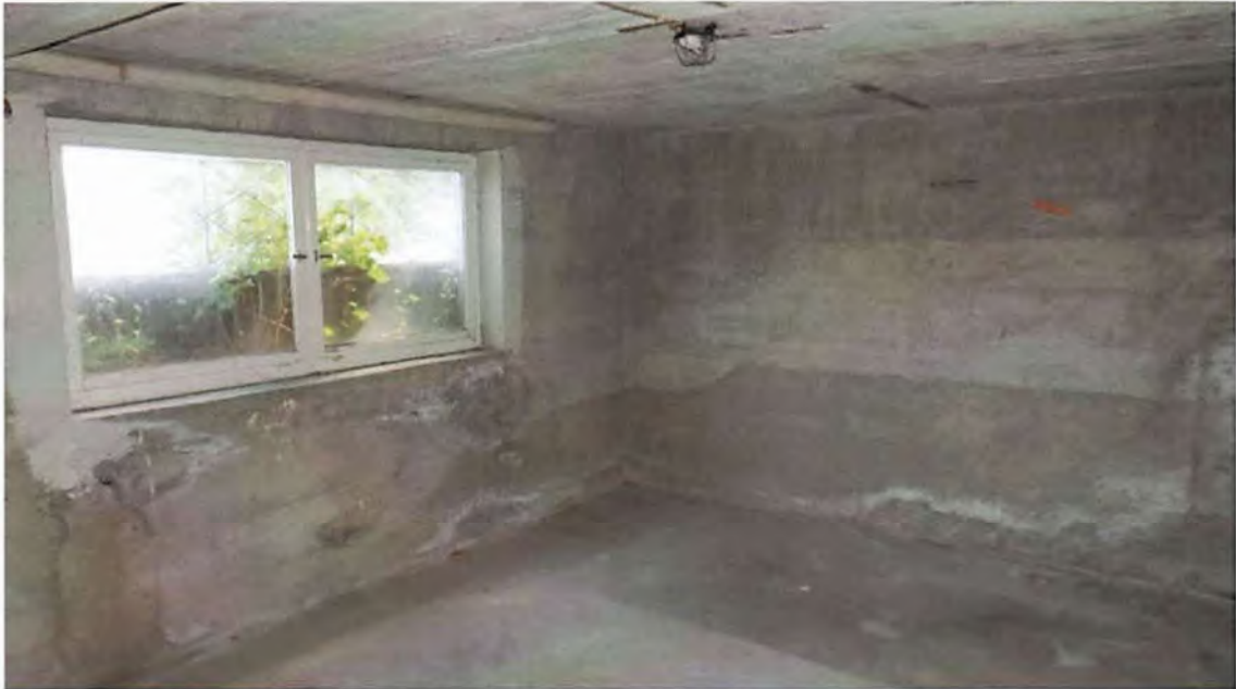
Bild 17: Kellerraum im Anbau von 1964
