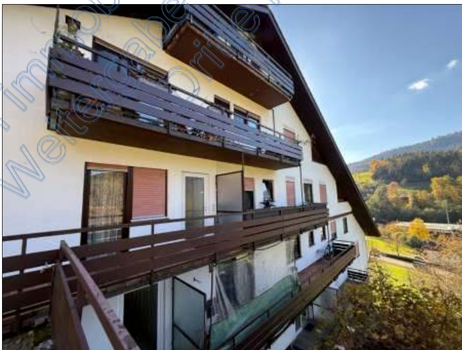
Bild 6: Nordfassade mit Balkonen
