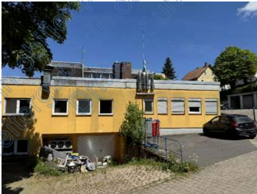
Bild 6: Gebäudeansicht von Südwesten
