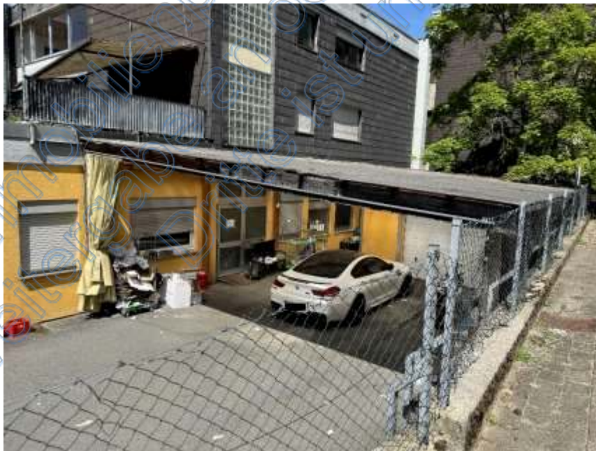
Bild 4: Gebäudeansicht von Süden
