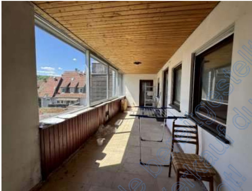
Bild 21: Laubengang im 2. Obergeschoss mit Zugängen zu den Wohnungen
