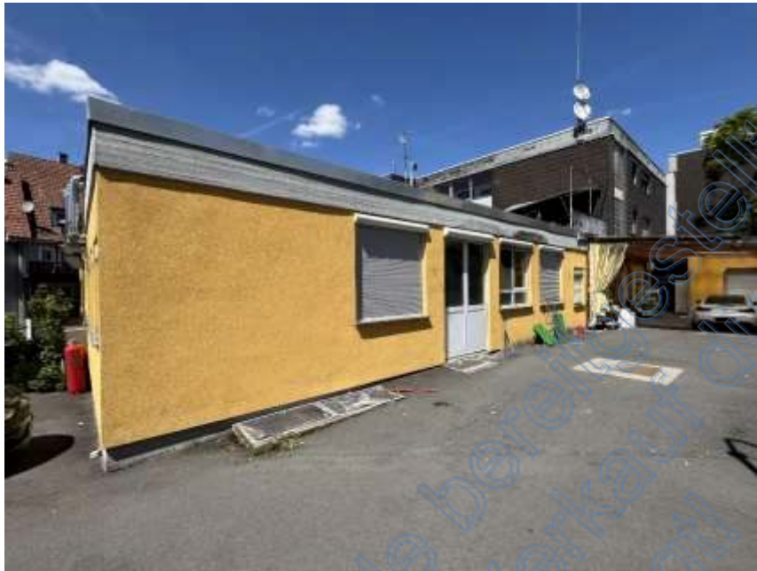
Bild 5: Gebäudeansicht von Südosten
