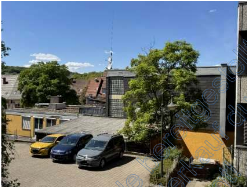
Bild 3: Gebäudeansicht von Südosten
