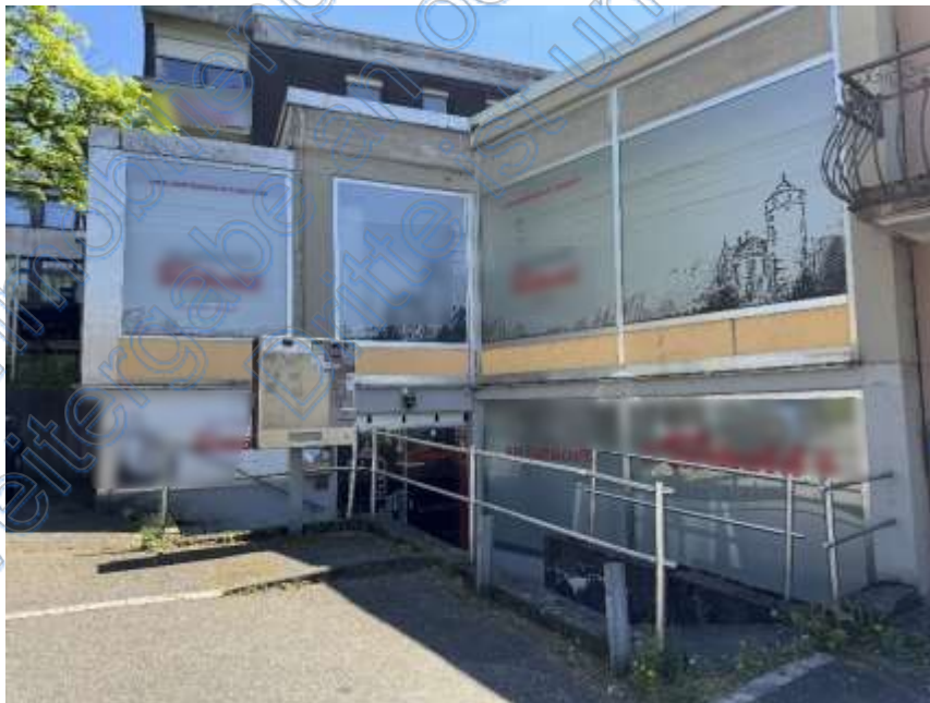
Bild 8: Gebäudeansicht von Norden
