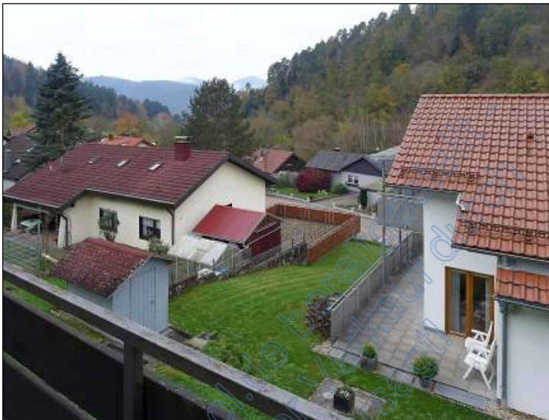
Bild 13 – Blick vom Balkon nach Nordwesten
