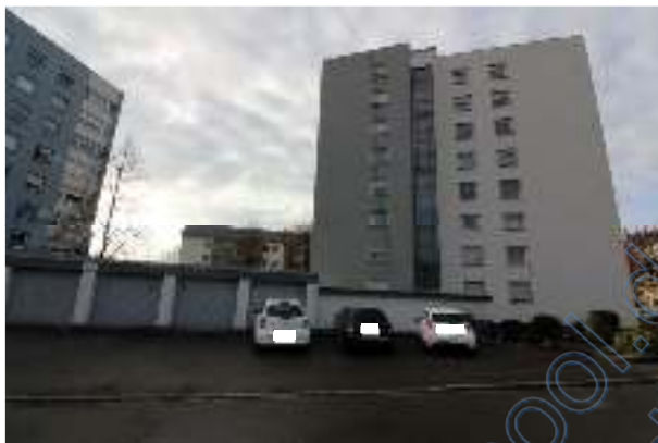
Ansicht Gebäude Hasenrichte 14
