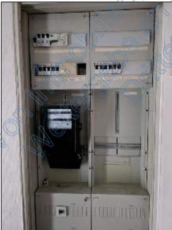
Elektrounterverteilung
