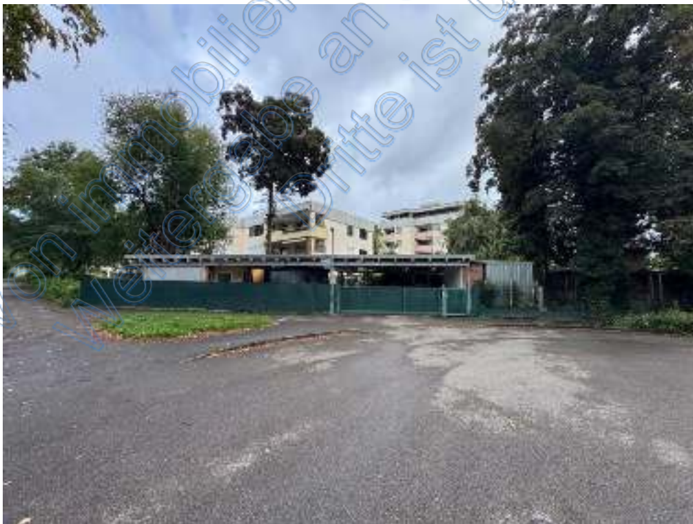
Ansicht Süd-West, mittig das nördlich liegende Nachbargebäude
