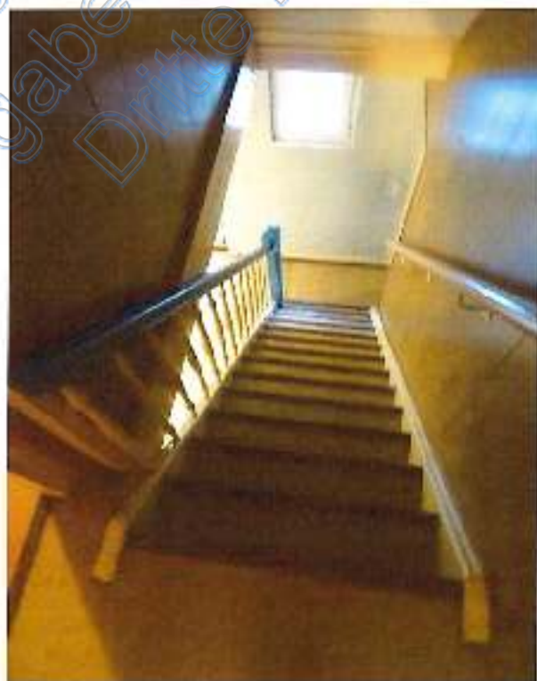
Foto 22: Treppe EG DG
