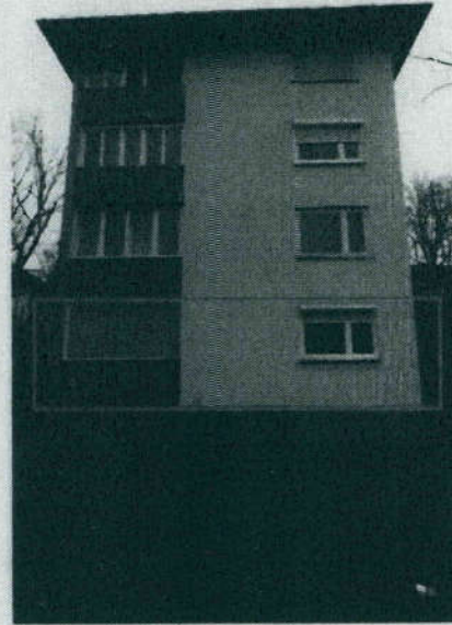
Bild 6: Ansicht Gebäude aus Westen
