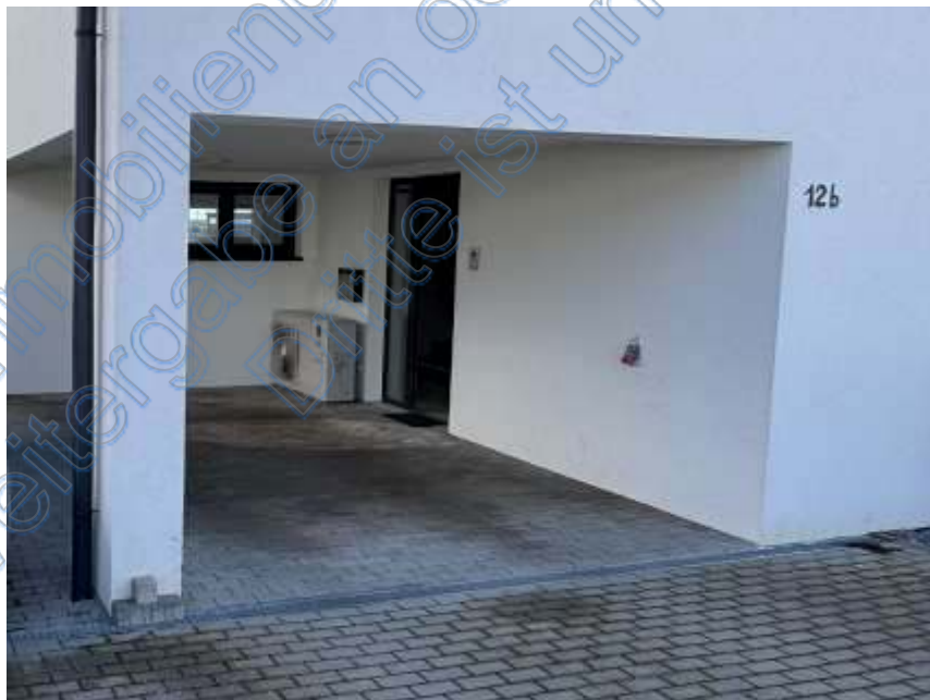
Bild 18: Integrierter Carport-Stellplatz im Erdgeschoss
