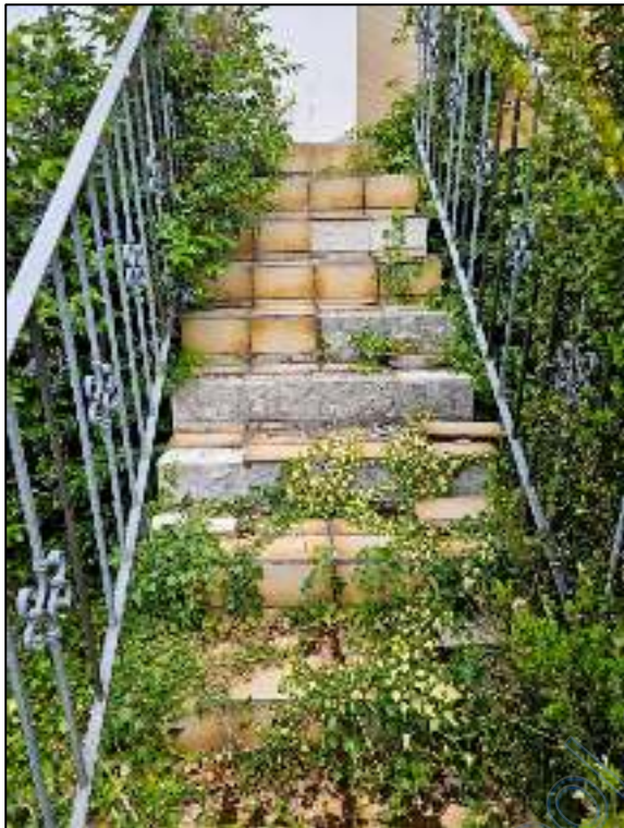
Abgangstreppe zum Garten
