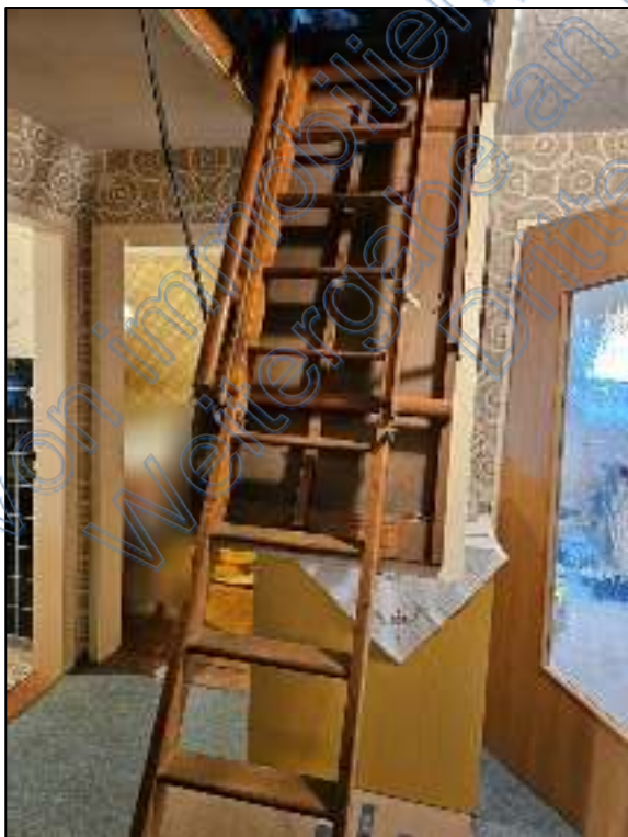
Einschubtreppe zum Spitzboden
