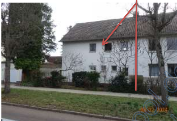
Straßenansicht Doppelhaushälfte Spielberger Straße 5
