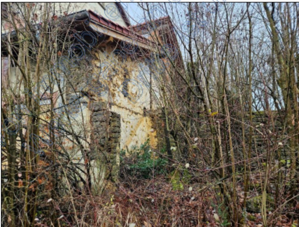
Grenzstehende Reste des abgebrochenen Wohnhauses (07.12.2025)
