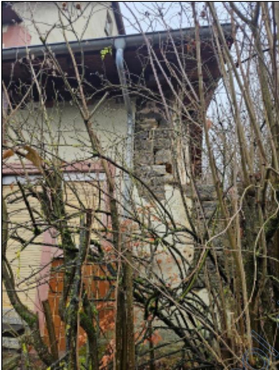
Grenzstehende Reste des abgebrochenen Wohnhauses (07.12.2025)
