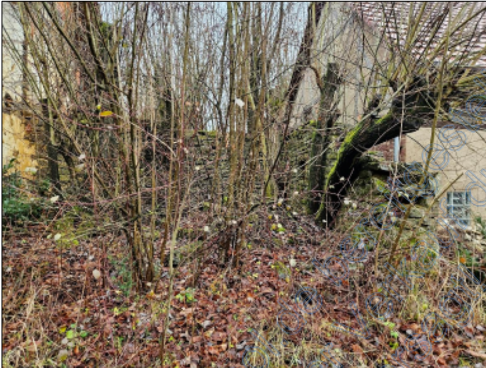
Reste des abgebrochenen Wohnhauses (07.12.2025)
