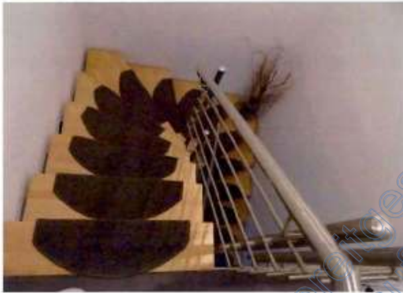
Foto 8: Treppe des Einfamilienhauses
