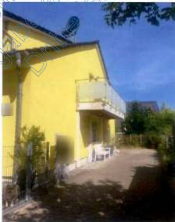
Foto 2: Blick auf die Ostseite des Wohnungseigentums Nr. 2 Eingangsbereich
