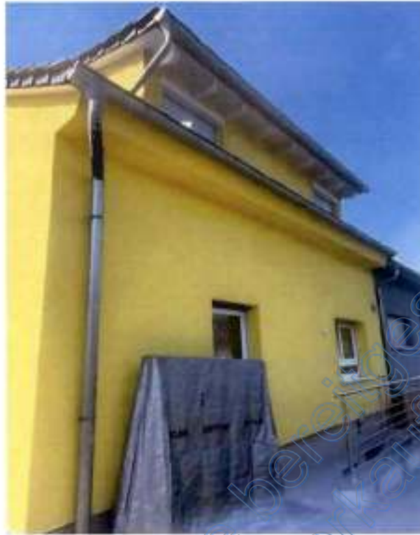
Foto 3: Blick auf den Kellerabgang auf der Nordseite
