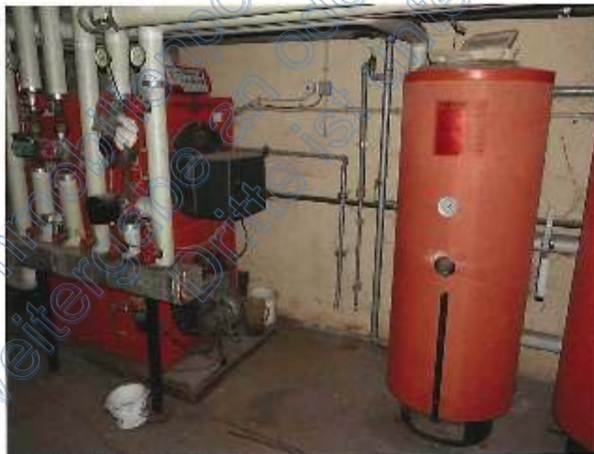
Bild 20: Holzungsanlage mit Warmwasserboiler
