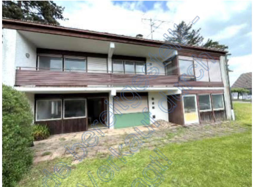
Foto 3 des SV: Ansicht von Süden, Gebäuderückseite
