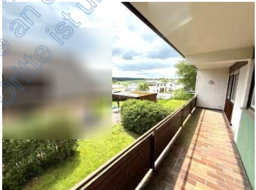
Foto 8 des SV: Wohnung EG; Balkon/Loggia
