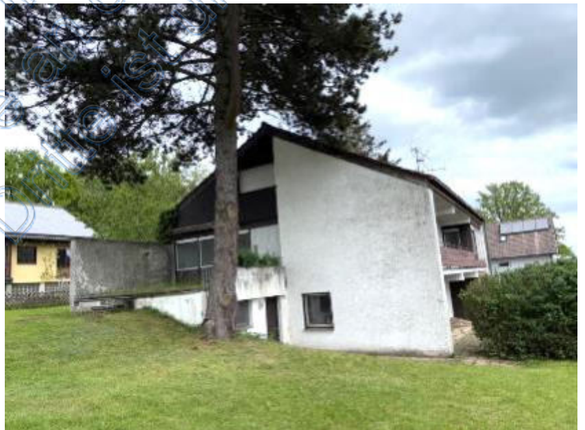
Foto 4 des SV: Ansicht von Südwesten
