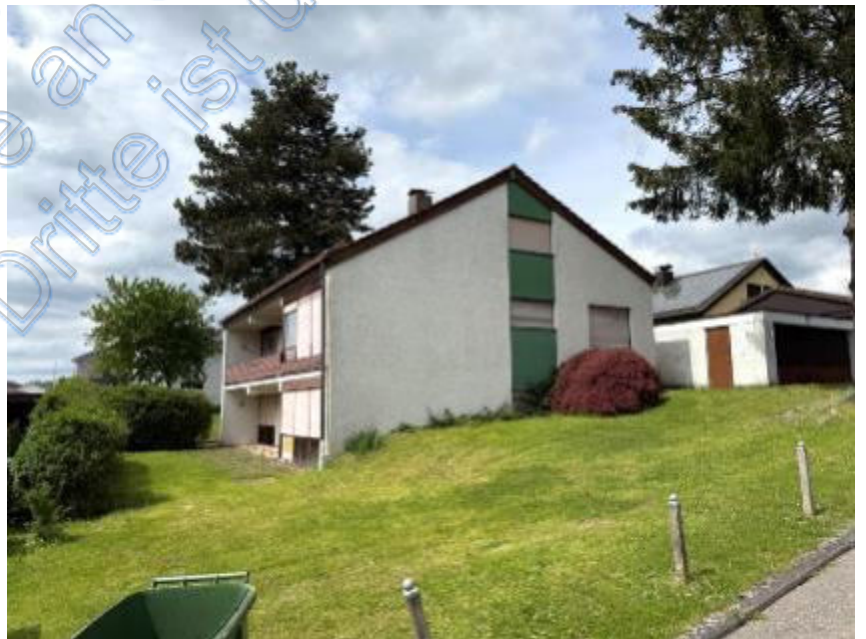
Foto 2 des SV: Ansicht von Südosten
