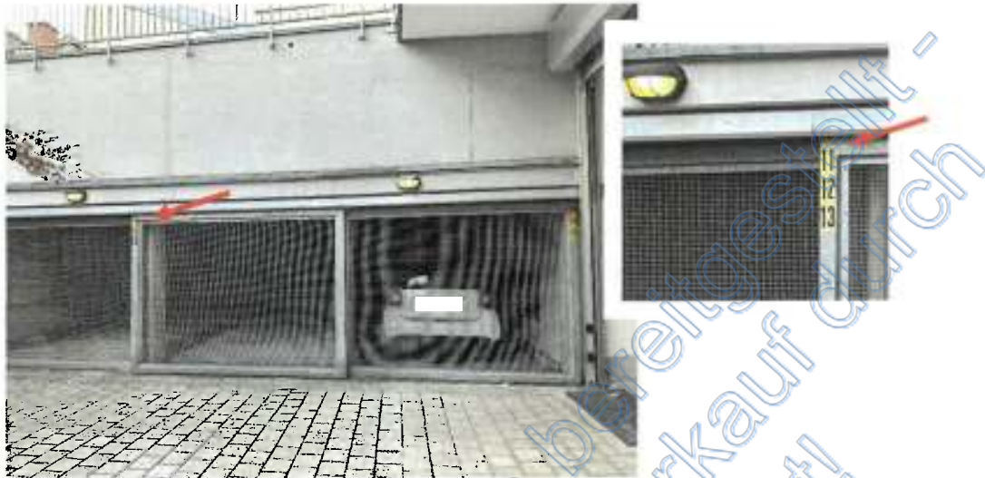
1 Blick auf das Garagengebäude mit halbautomatischem Paletten-Parksystem rechts der Einfahrt.
