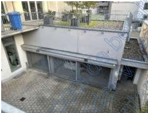
18 Blick auf die Garage mit halbautomatischem Paletten-Parksystem links der Einfahrt.
