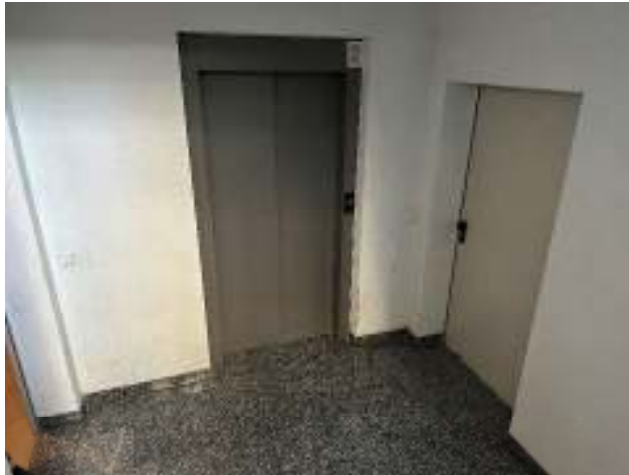
13 Blick auf den Aufzug und die Kellerzugangstür im Untergeschoss.
