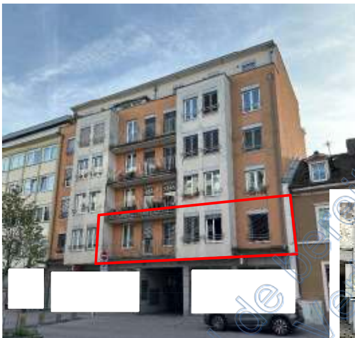
1 Blick auf das Grundstück „Palmstraße 30“ von Nordosten.
