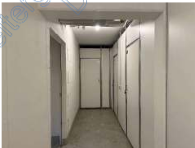
14 Blick in den Kellerflur.
