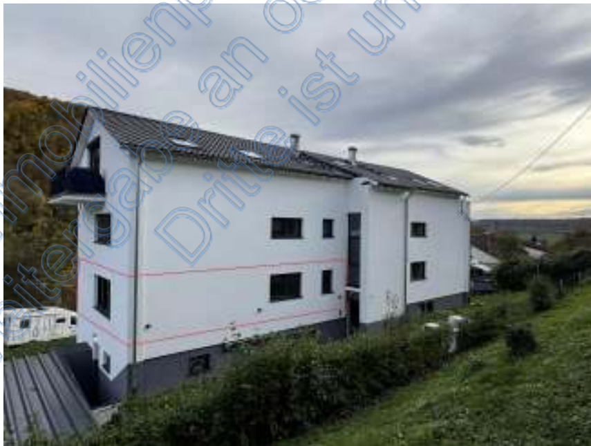
Bild 2: Gebäudeansicht von Norden mit rot markiertem Bewertungsobjekt
