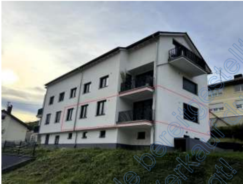
Bild 1: Gebäudeansicht von Nordosten mit rot markiertem Bewertungsobjekt
