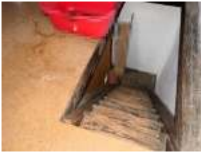
Treppe Dachspitz ins DG
