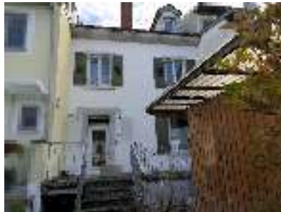
Ansicht vom Grundstück
