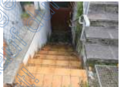
Kelleraußentreppe mit Eingang KG
