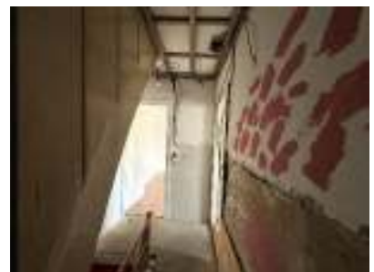
OG Flur Richtung Schlafzimmer
