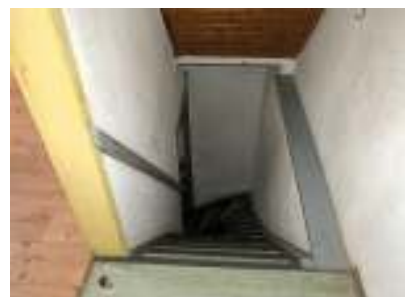
Treppe DG ins OG
